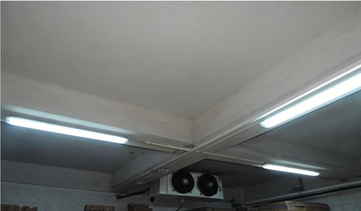
Şekil 4.33. Sancaktepe ilçesindeki bir işletmenin konvansiyonel betonarme tavan sistemi
