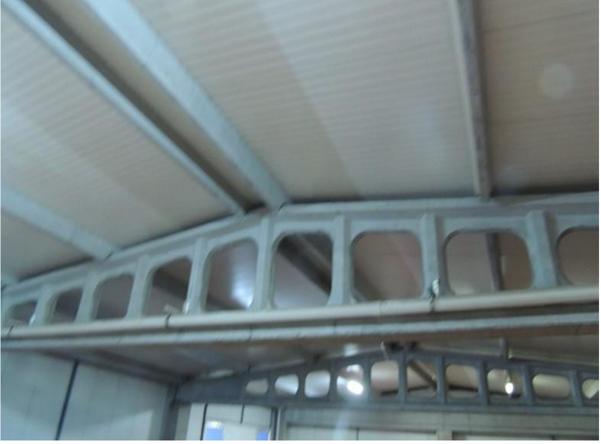
Şekil 4.27. Taşıyıcı sistem olarak prefabrik kullanıldığı başka bir işletme (Sancaktepe)
