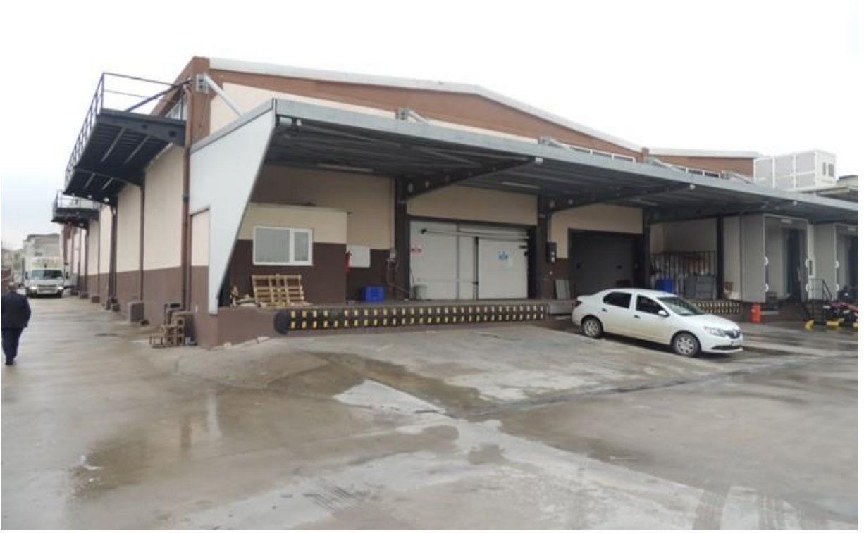
Şekil 4.2. İşletmenin kapalı alanının dıştan genel görünümü (Pendik)
