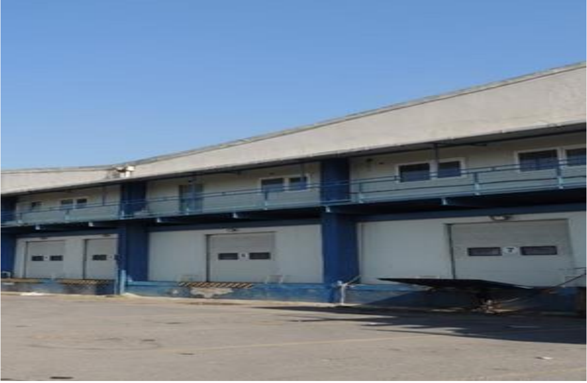
Şekil 4.30. Duvar yapı malzemesi olarak briket ve PU panel kullanılan bir depodan görünüm (Pendik)
