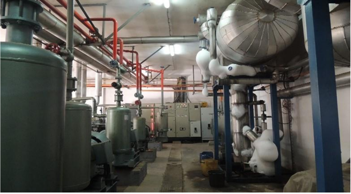
Şekil 4.11. Freon ve amonyak gazı ile soğutma yapan başka bir deponun mekanik odası (Tuzla)
