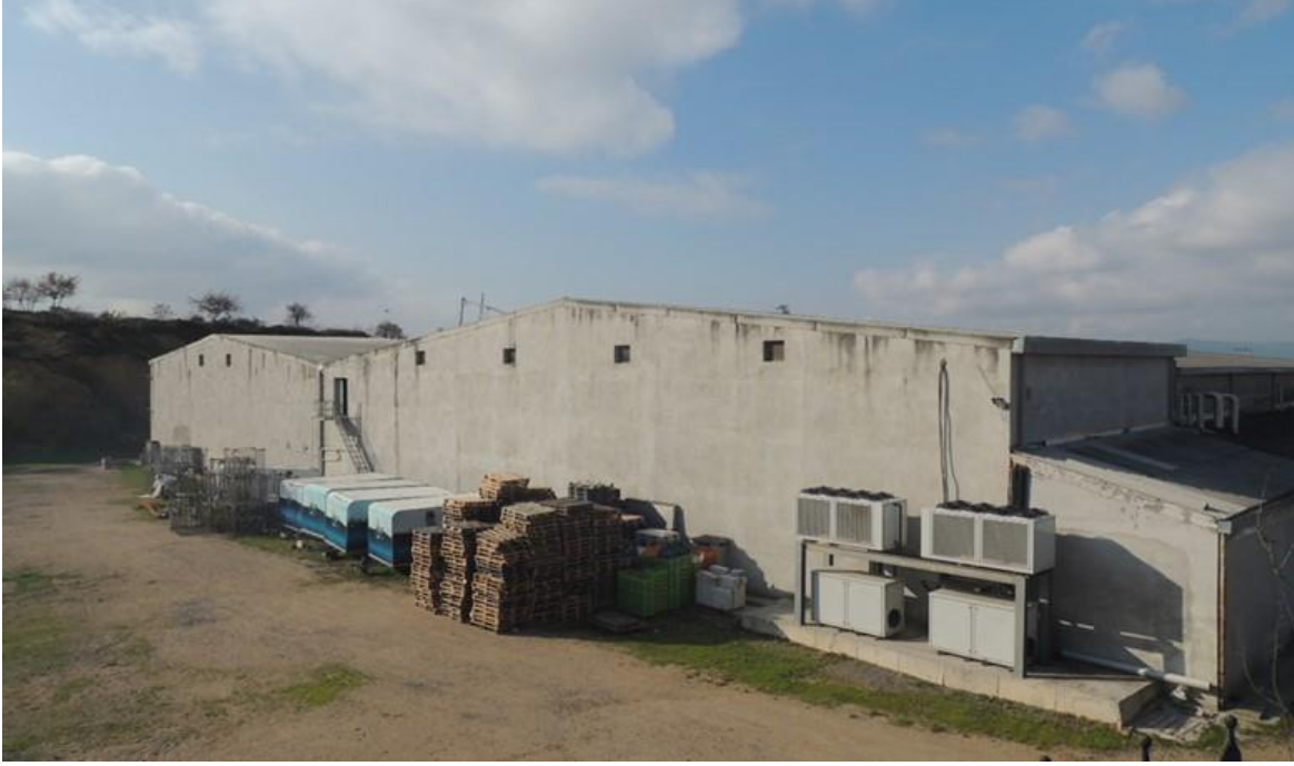
Şekil 4.32. Duvar yapı malzemesi tuğla kullanılan depodan görünüm (Tuzla)
