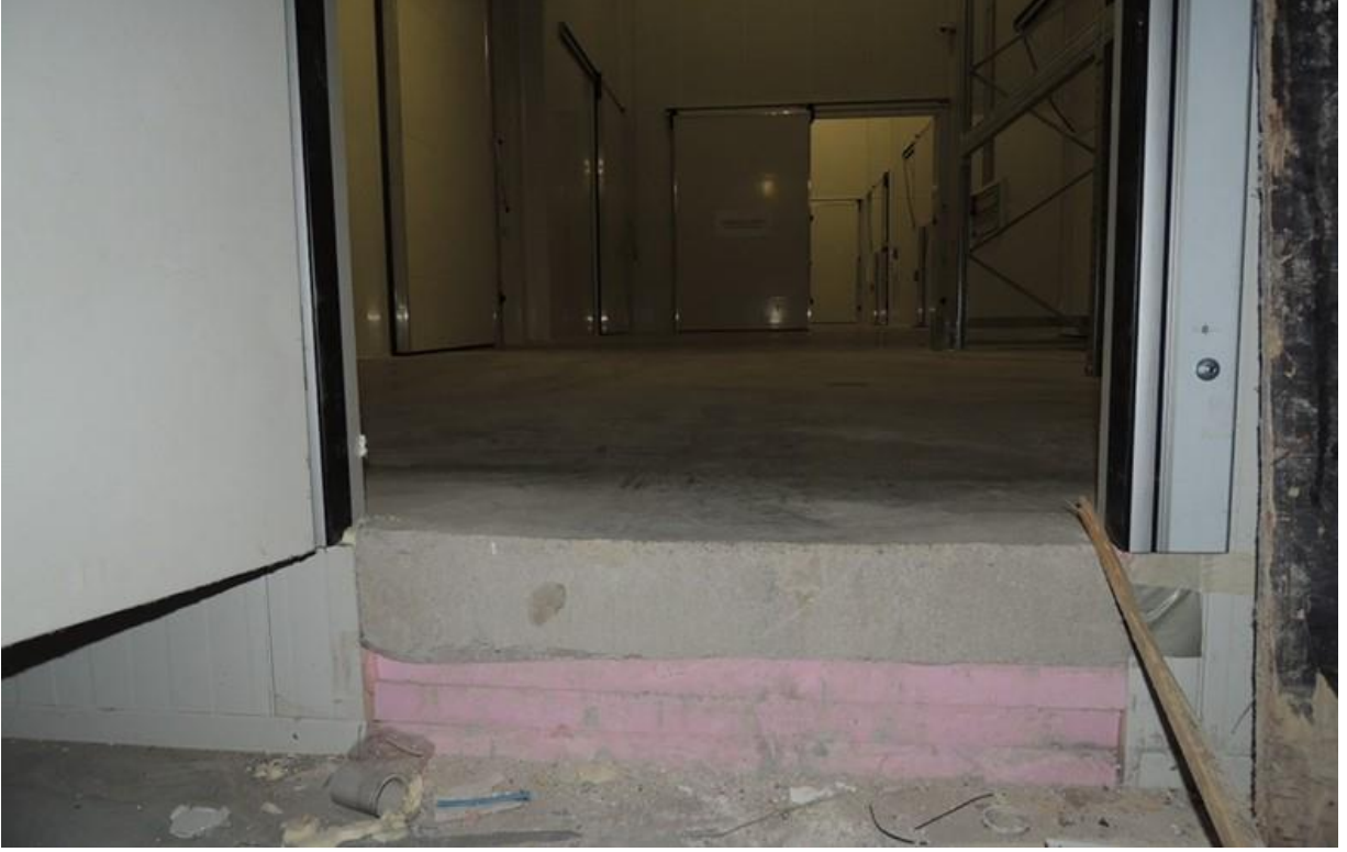
Şekil 4.39. Taban yalıtımında PU köpük kullanılan depo tabanından enine bir kesit (Tuzla)
