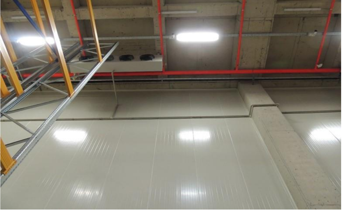
Şekil 4.37. Çatı örtü malzemesi EPS ve PU köpük kullanılmış bir işletme (Tuzla)
