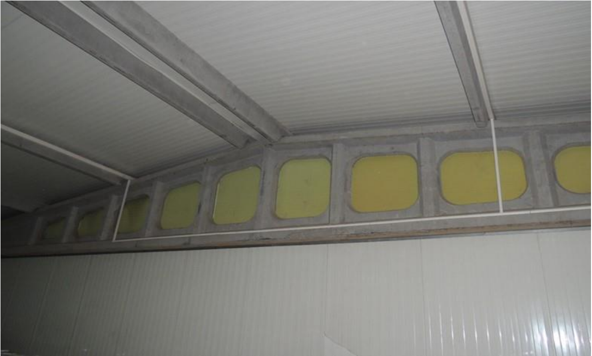
Şekil 4.38. Çatı örtü malzemesi PU panel kullanılmış depodan genel bir görünüm (Sancaktepe)
