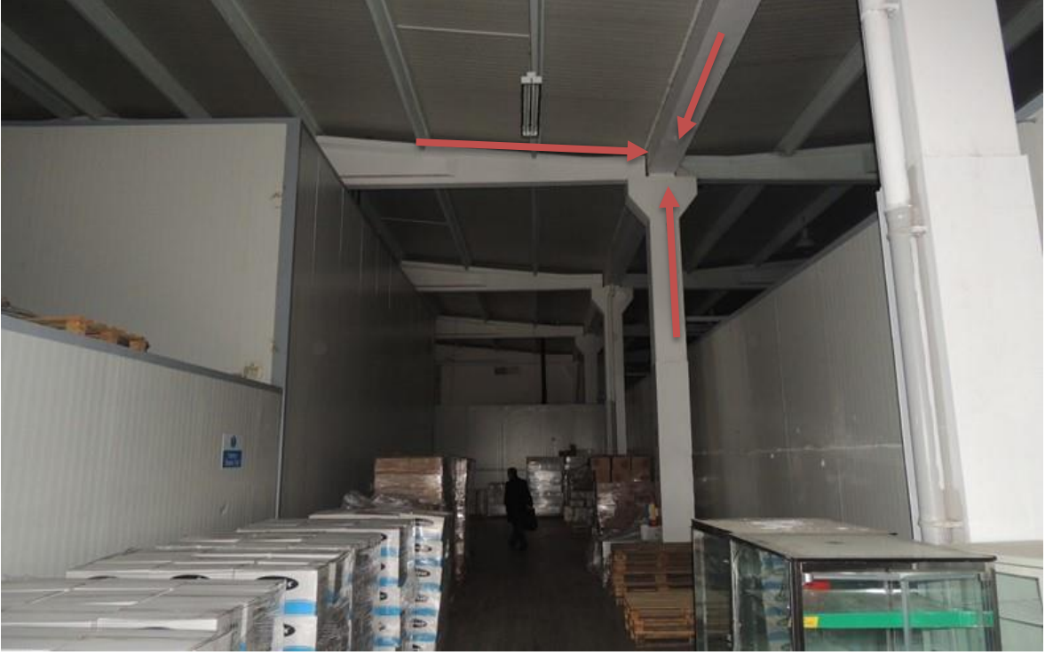
Şekil 4.25. Taşıyıcı sistem olarak prefabrik betonarmenin kullanıldığı bir işletme (Pendik)
