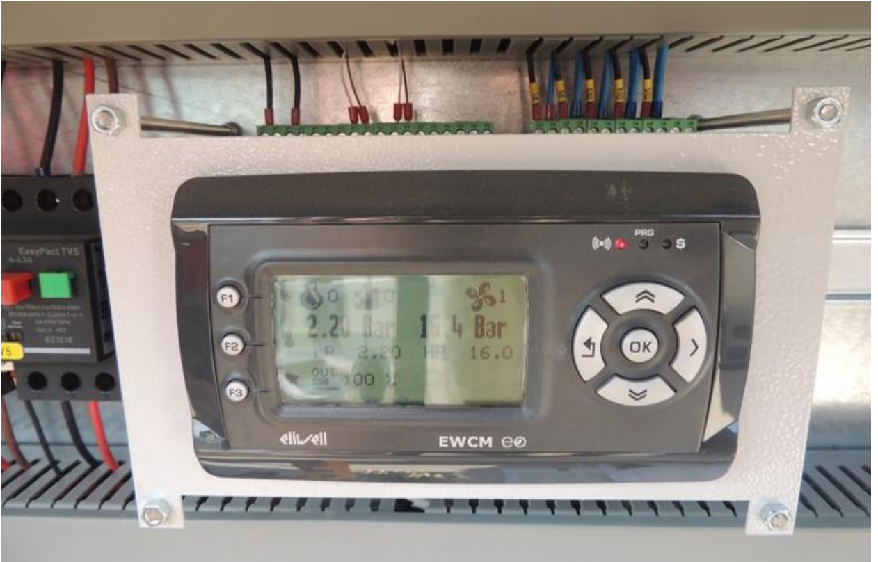
Şekil 4.20. İşletmede sıcaklık ve nemin merkezden kontrol edilebilen bir cihaz (Tuzla
