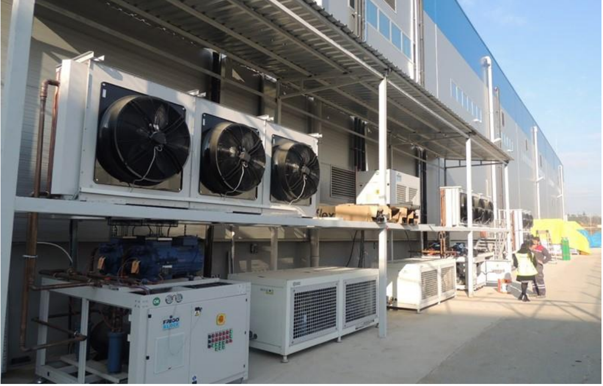
Şekil 4.15. Tuzla ilçesindeki soğuk hava deposunun soğutma sisteminden genel görünüm
