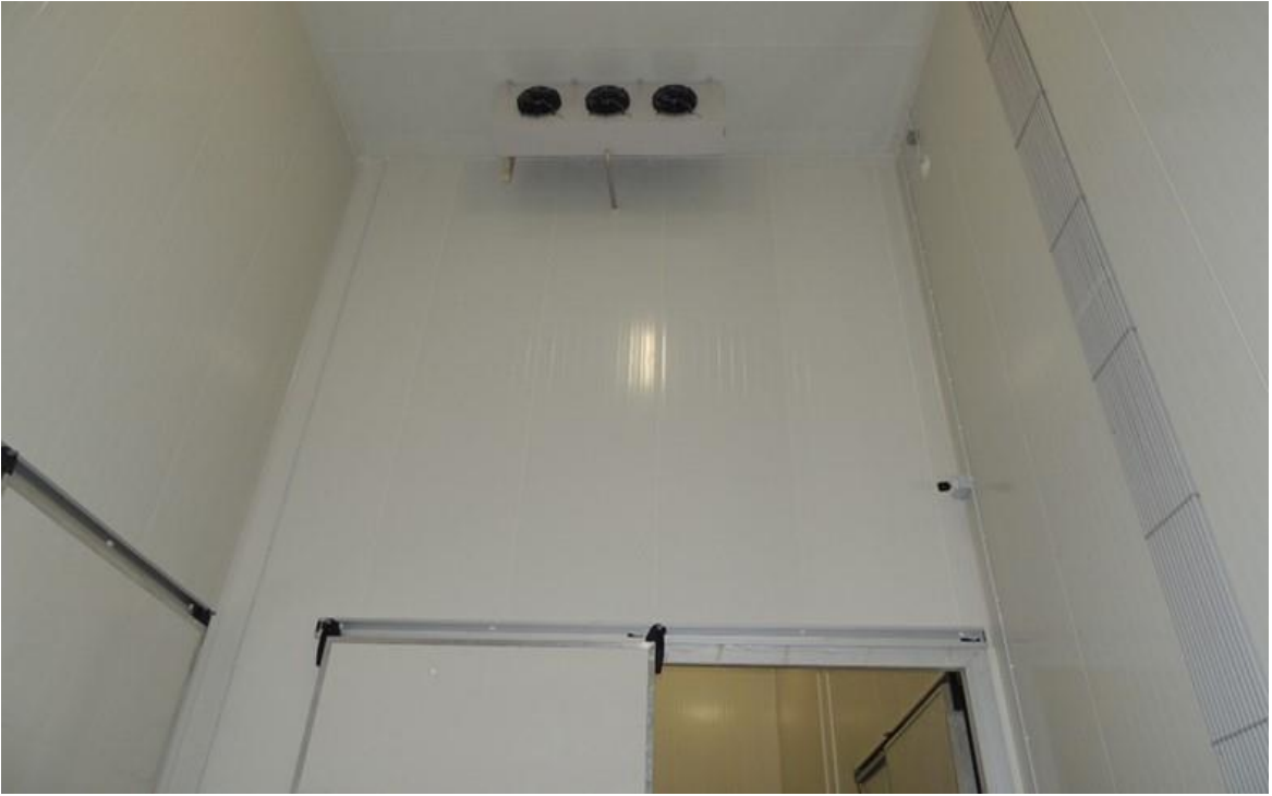
Şekil 4.31. Duvar yapı malzemesi PU panel kullanılan bir depodan görünüm (Tuzla)
