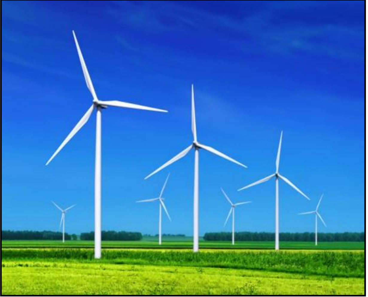
Şekil 1.12. Üç kanatlı rüzgar türbin örneği (Anonim 2019b)
