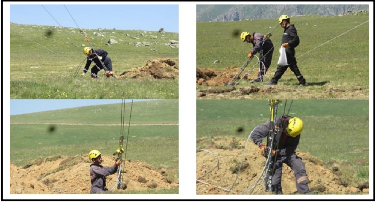
Şekil 3.9. Rüzgar ölçüm istasyonu montajı - 2
