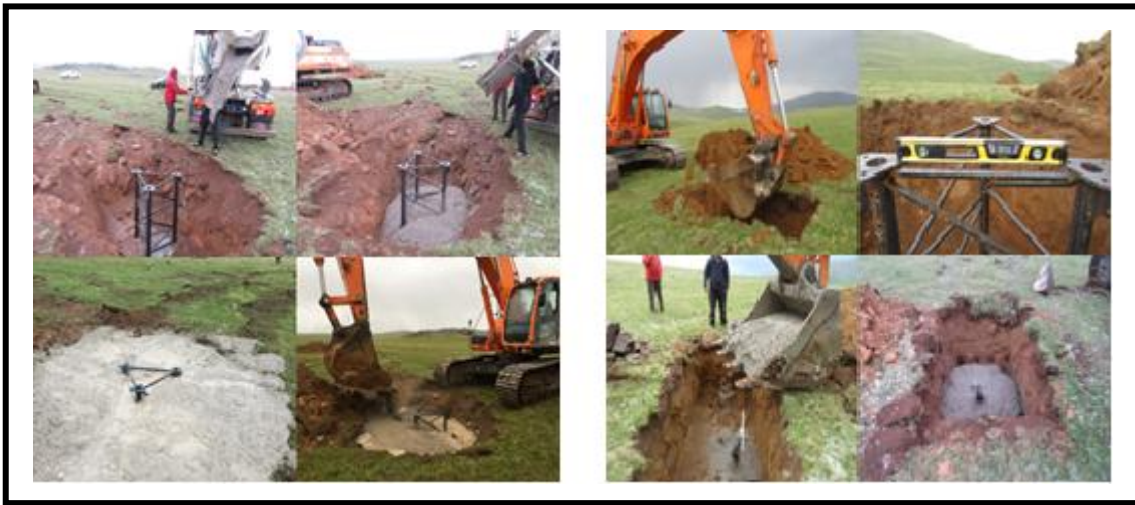
Şekil 3.8 Rüzgar ölçüm istasyonu montajı – 1
