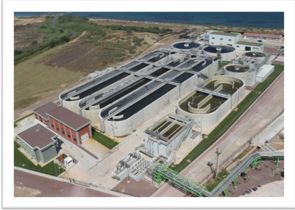
Şekil 4.2 İncelenen OSB Atıksu Arıtma Tesisinden Bir Görünüş
