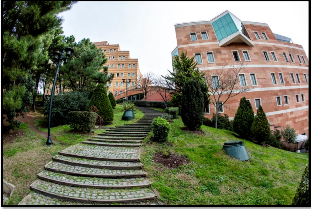
Şekil 4.38. Çalışma alanında uygulaması gerçekleştirilen rampa uygulamaları (Anonim 2018)
