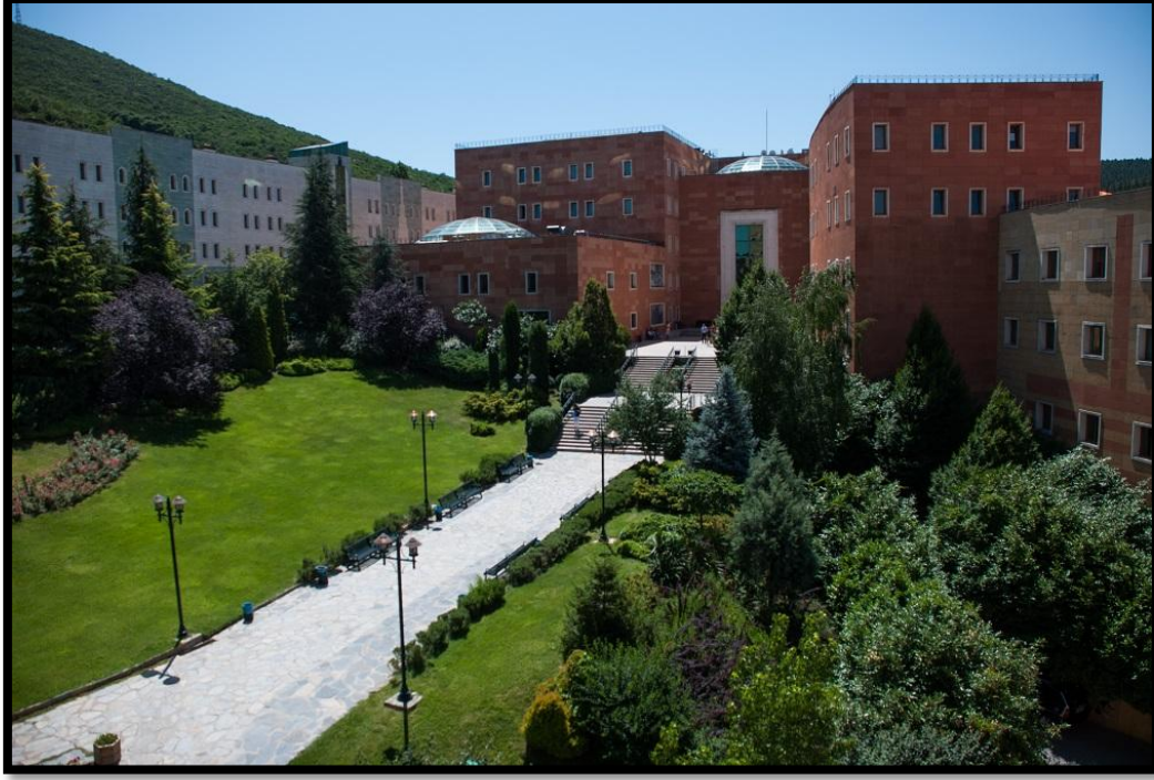
Şekil 4.43. 26 Ağustos Yerleşkesi Güzel Sanatlar Tasarım ve Mimarlık Fakültesi aydınlatma birimleri ve peyzaj düzenlemesi
