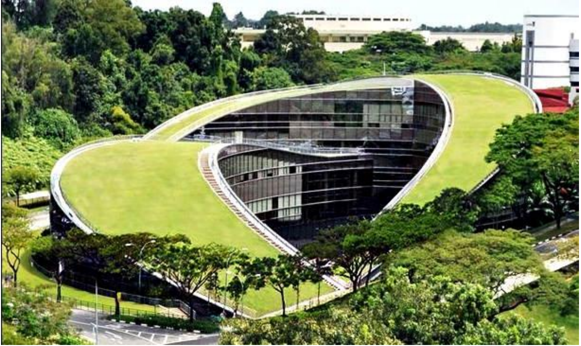
Şekil 2.19. Singapur Nanyang Teknik Üniversitesi (Anonim 2018)
