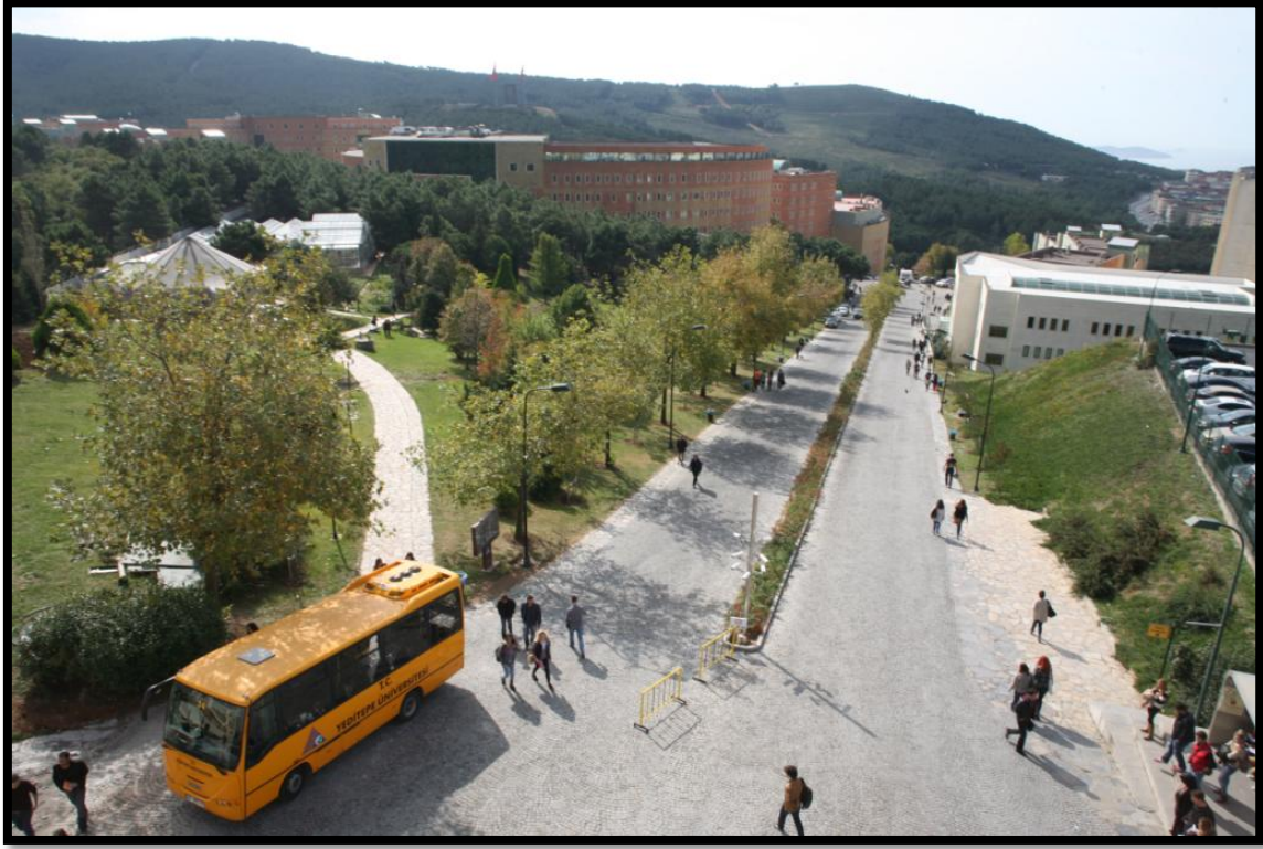
Şekil 4.13. Yeditepe üniversitesi yerleşkesi üst giriş kapısından bir görünüm (Anonim 2018).
