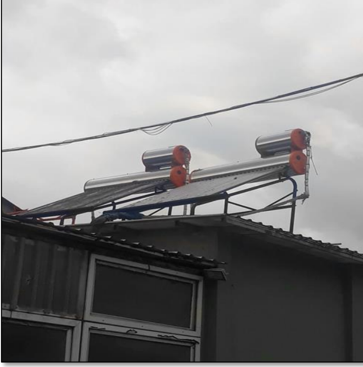
Şekil 3.4. Projelendirmesi yapılan güneş kolektör sistemi
