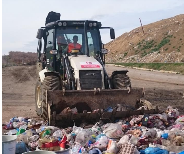
Şekil 5.7. Atık Yığının Boşaltılması ve Düzleştirilmesi
