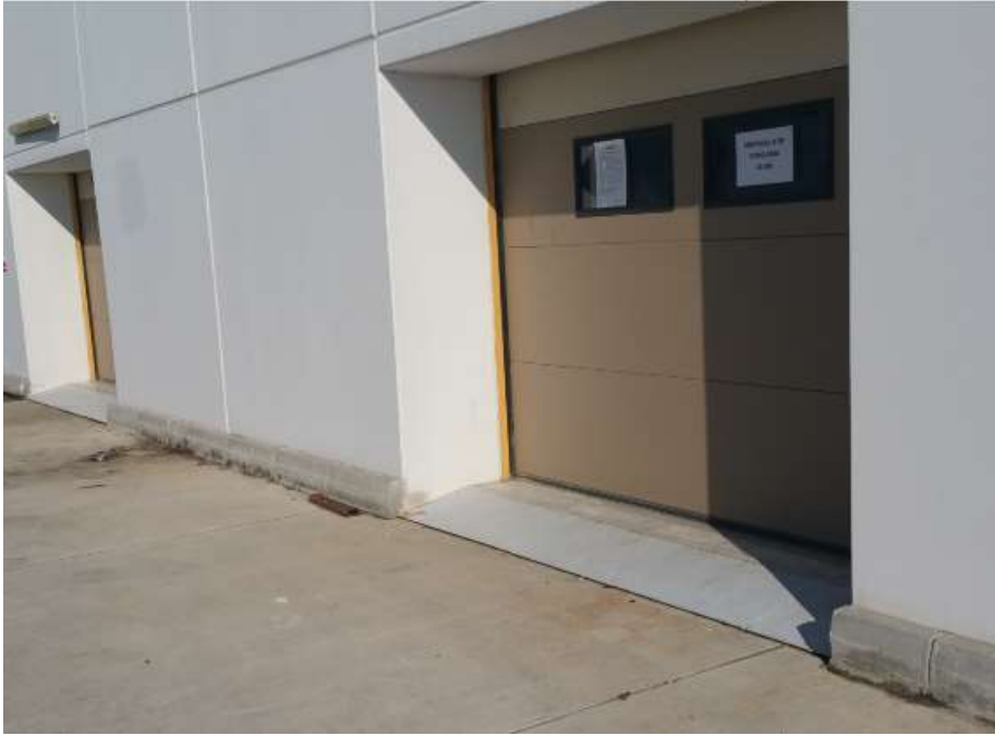
Şekil 4.6.: Geçici Atık Depolama Alanı
