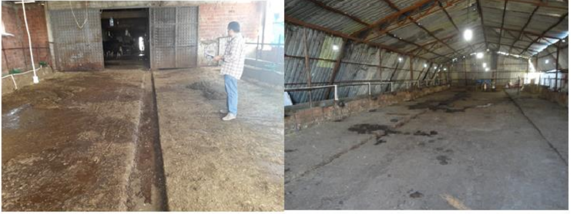
Şekil 4.3. İdrar kanalı ve servis yolu düzgün planlanmamış ahırlar
