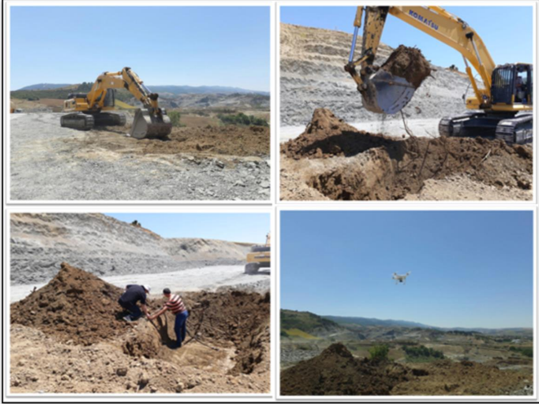
Resim 3.3: İHA doğruluk tespiti için açılan çukur
