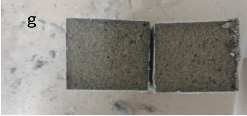
Şekil 4.5. Şahit numunenin beton görüntüsü
