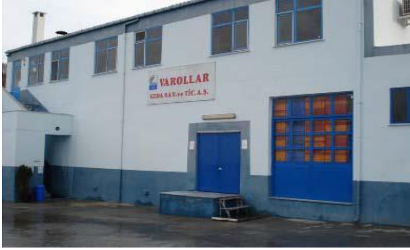
Şekil 8.1.2.1: Tesis binasının dıştan görünüşü Varollar Gıda San. ve Tic. A.Ş.
