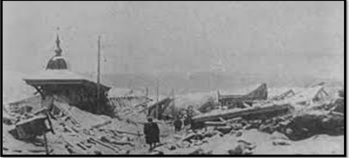
Şekil 2.11. Muş-Varto depreminde yıkılan binalardan görünüm ( http://www.dersimiz.com/bilgibankasi/VARTO-DEPREMI-HAKKINDA-BILGI-2295.html , Erişim tarihi 05.11.2015)
