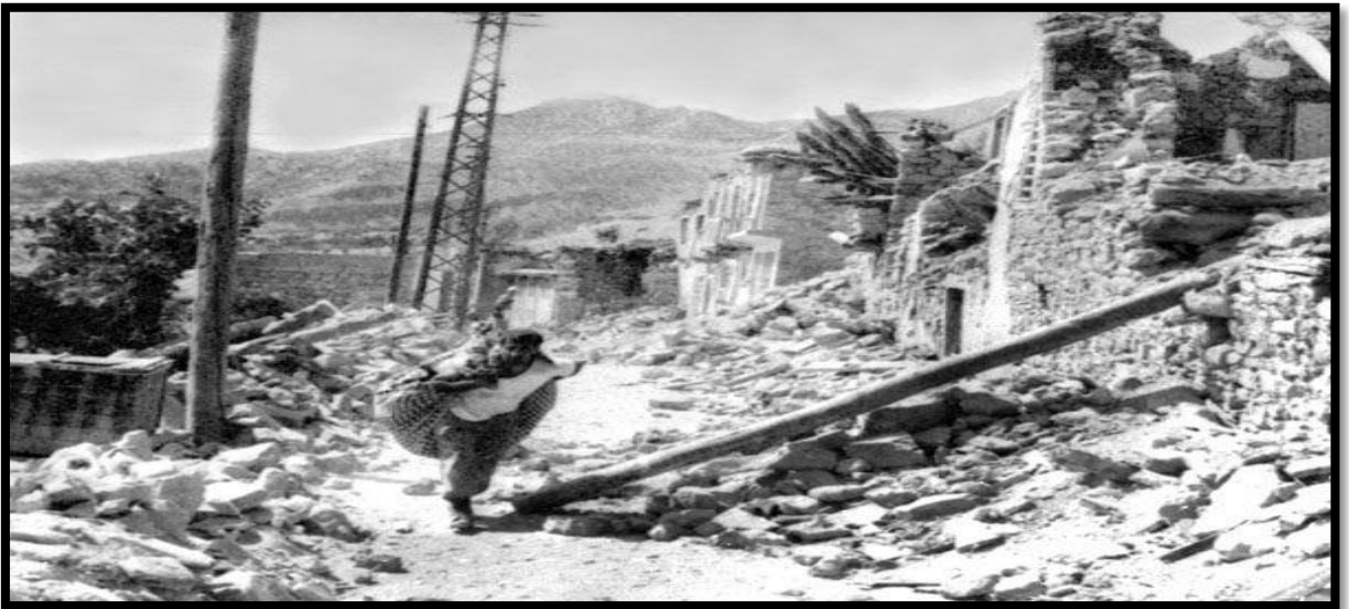
Şekil 2.12. Diyarbakır-Lice depreminde yıkılan binalardan görünüm ( http://www.tarihte bugun.org/17053-6-eylul-1975_diyarbakir_lice_depremi.html , Erişim tarihi 05.11.2015)
