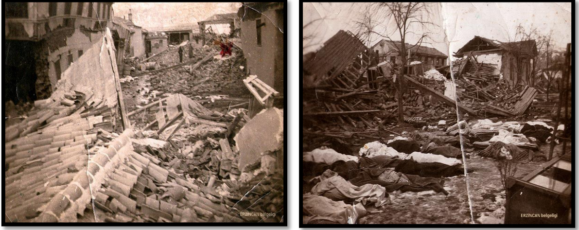
Şekil 2.7. Erzincan depreminde zarar görmüş binalardan görünüm (Anonim 2015a)
