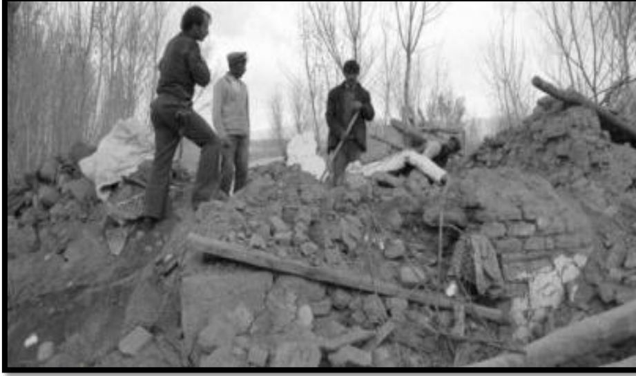
Şekil 2.13. Van-Muradiye depreminde yıkılan binalardan görünüm (Anonim 2015a)
