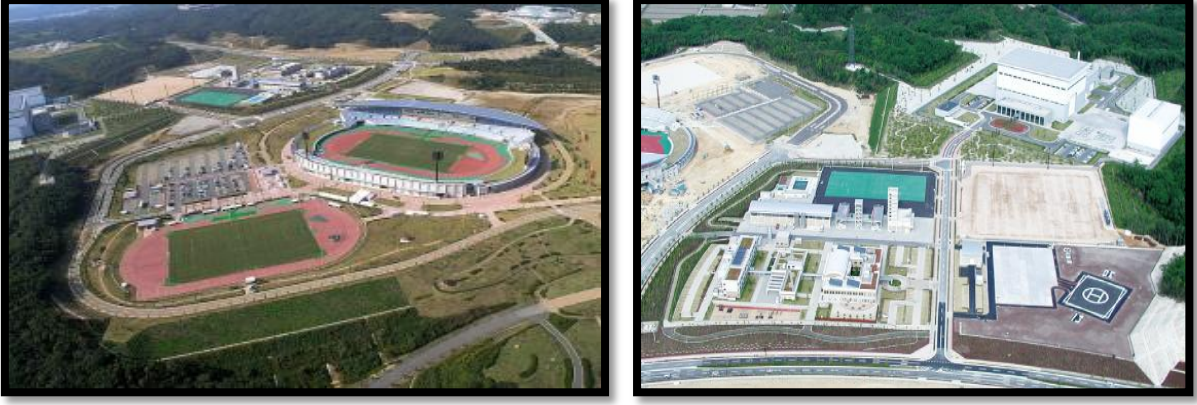
Şekil 2.28. Miki afet parkı futbol sahaları ve yönetim binasından görünüm (Anonim 2015k)
