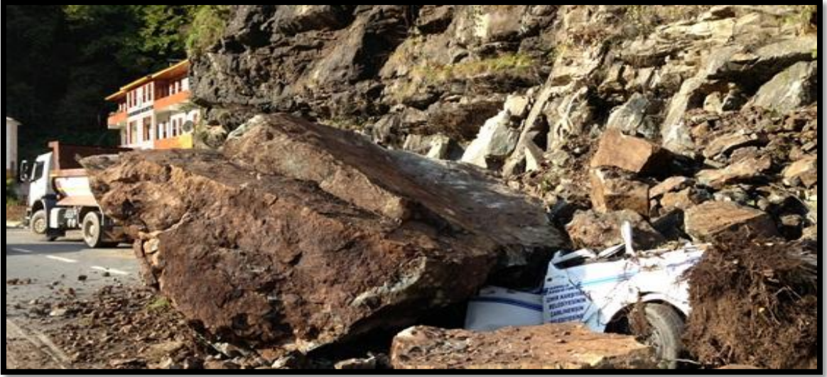
Şekil 2.6. Rize’de yaşanan kaya düşmesinde aracın zarar görmesinden bir görünüm ( http://www.kackar53.com/pazar-rize/dev-kaya-arac-ustune-dustu-h2209.html , Erişim tarihi: 12.10.2015)
