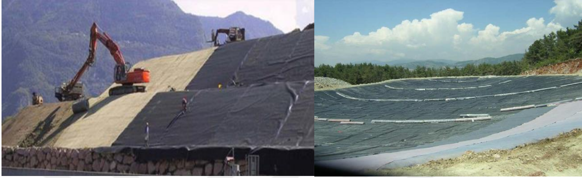
Şekil 2.5. Geomembran serimi [18,21]
