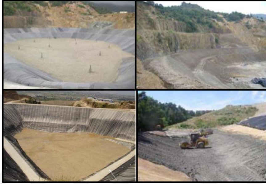
Şekil 2.4. Düzenli depolama sahasının hazırlanması [18]
