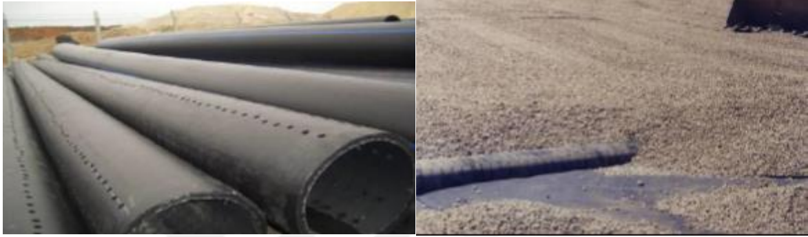
Şekil 2.7. Drenaj tabakasının oluşturulması [18]
