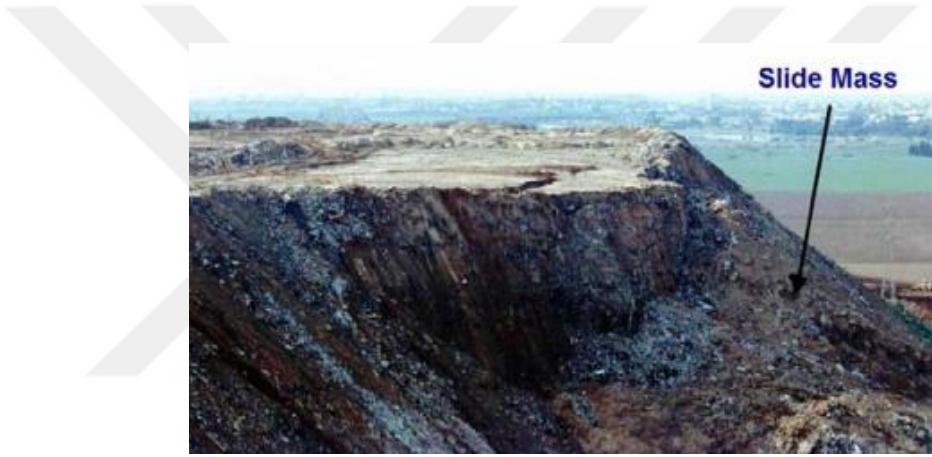
Şekil 4.4. 1997' de Hiriya depolama sahasında oluşan şev göçmesi [4]
