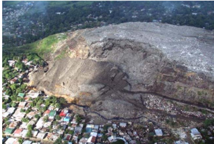
Şekil 4.6. 2000 yılında Payatas depolama sahasında şev göçmesi [4]
