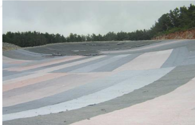
Şekil 2.6. Geotekstil serilmesi [21]
