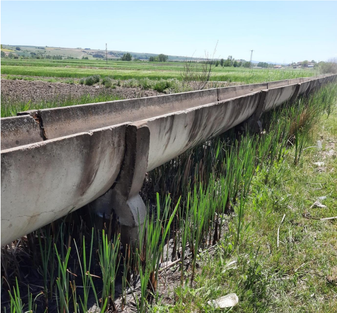
Şekil 4.2. Kanaletli Sulama Şebekesi
