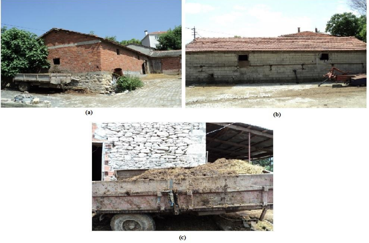
Şekil 4.30. Tuğla, briket ve taş malzeme kullanılan barınak duvarı örnek görünümleri
