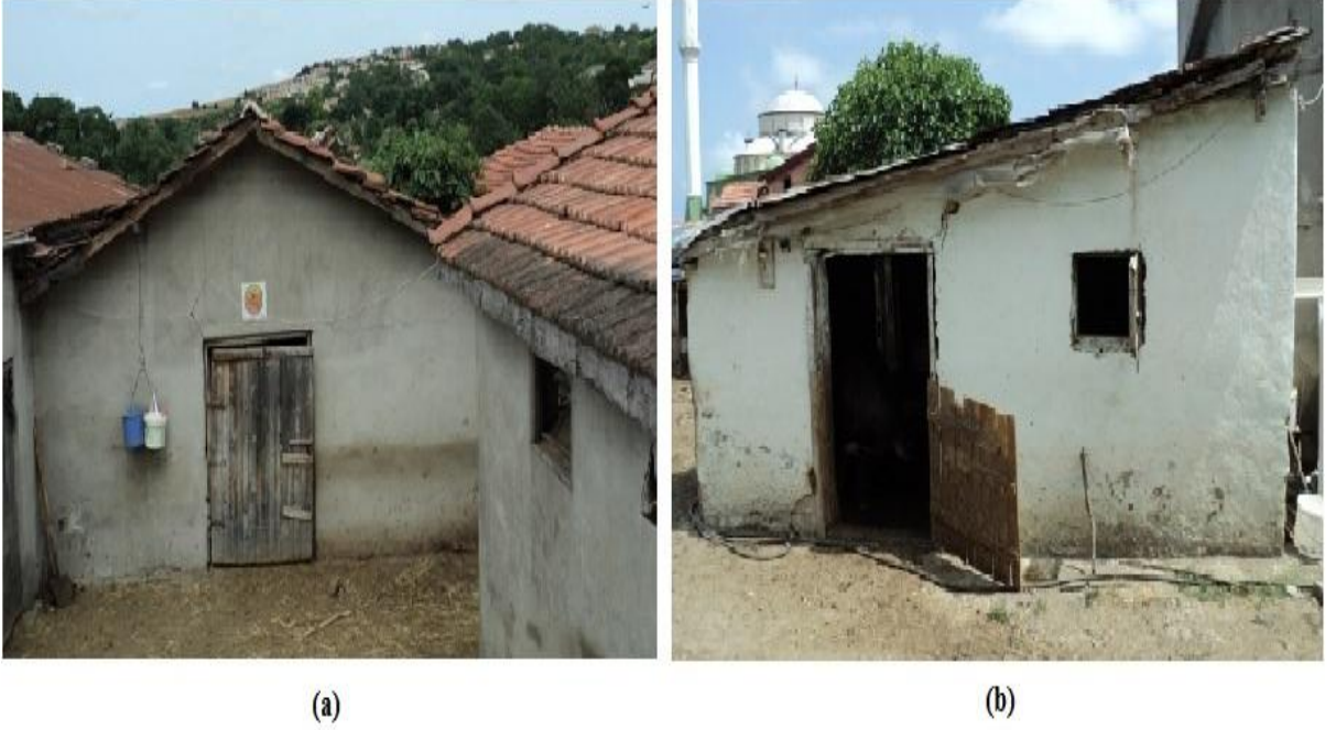
Şekil 4.33. Beşik ve sundurma tipli çatılı ahır örnekleri
