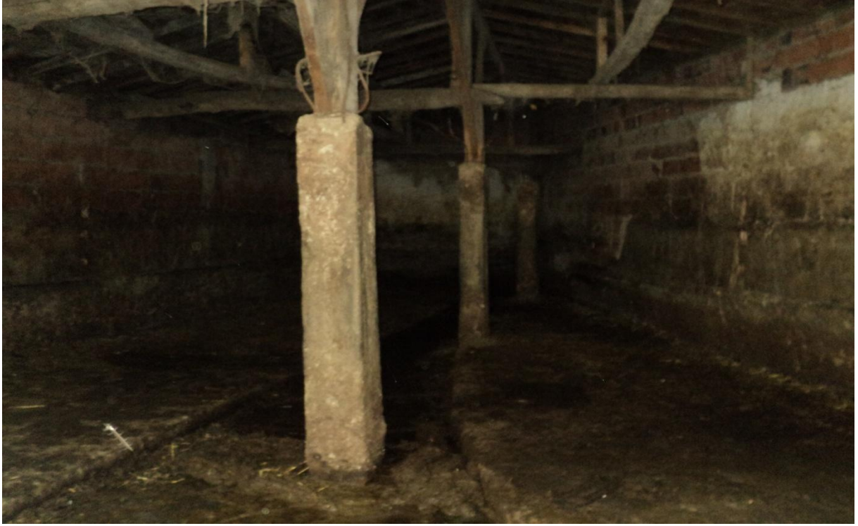
Şekil 4.26. Havalandırması ve aydınlatması yetersiz bir manda barınağı görünümü
