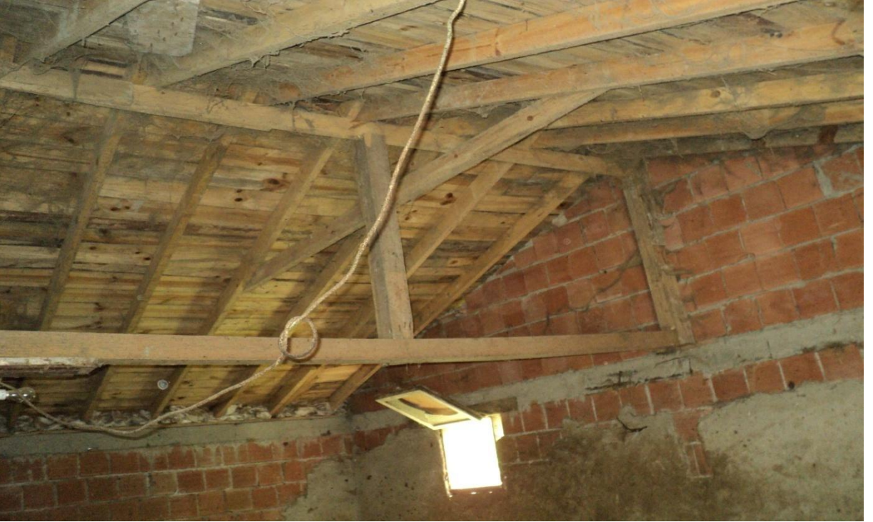
Şekil 4.31. Çatı iskelet malzemesi ahşap ahır
