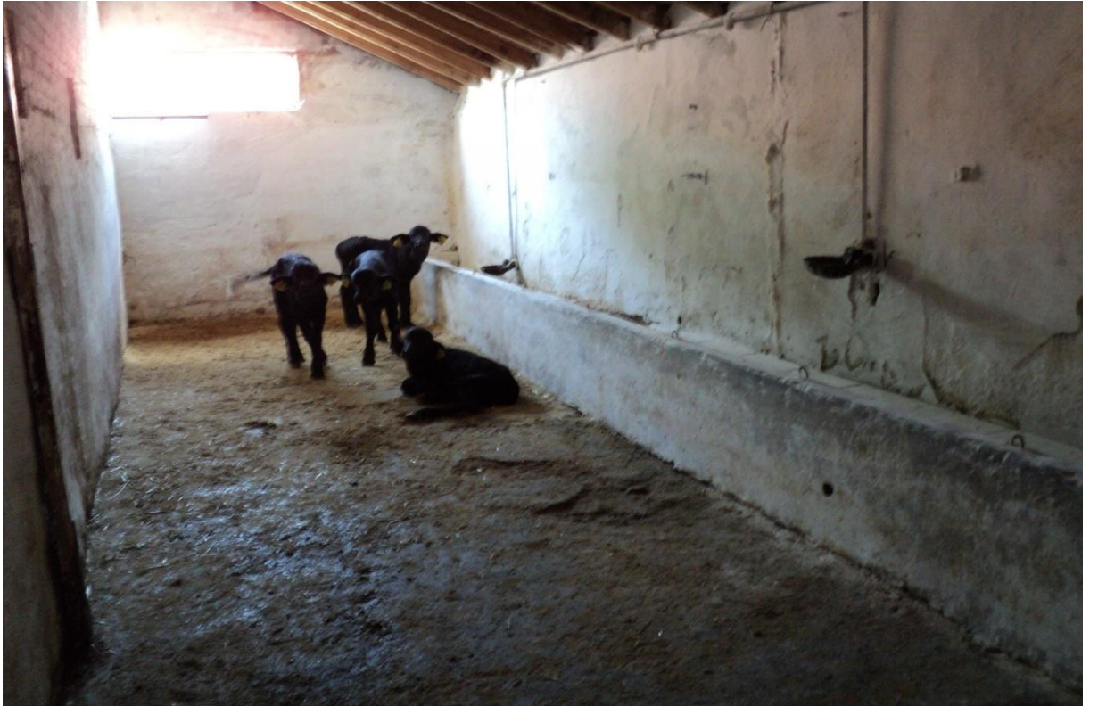
Şekil 4.27. İdrar kanalı olmayan tek sıralı bağlı duraklı bir ahır
