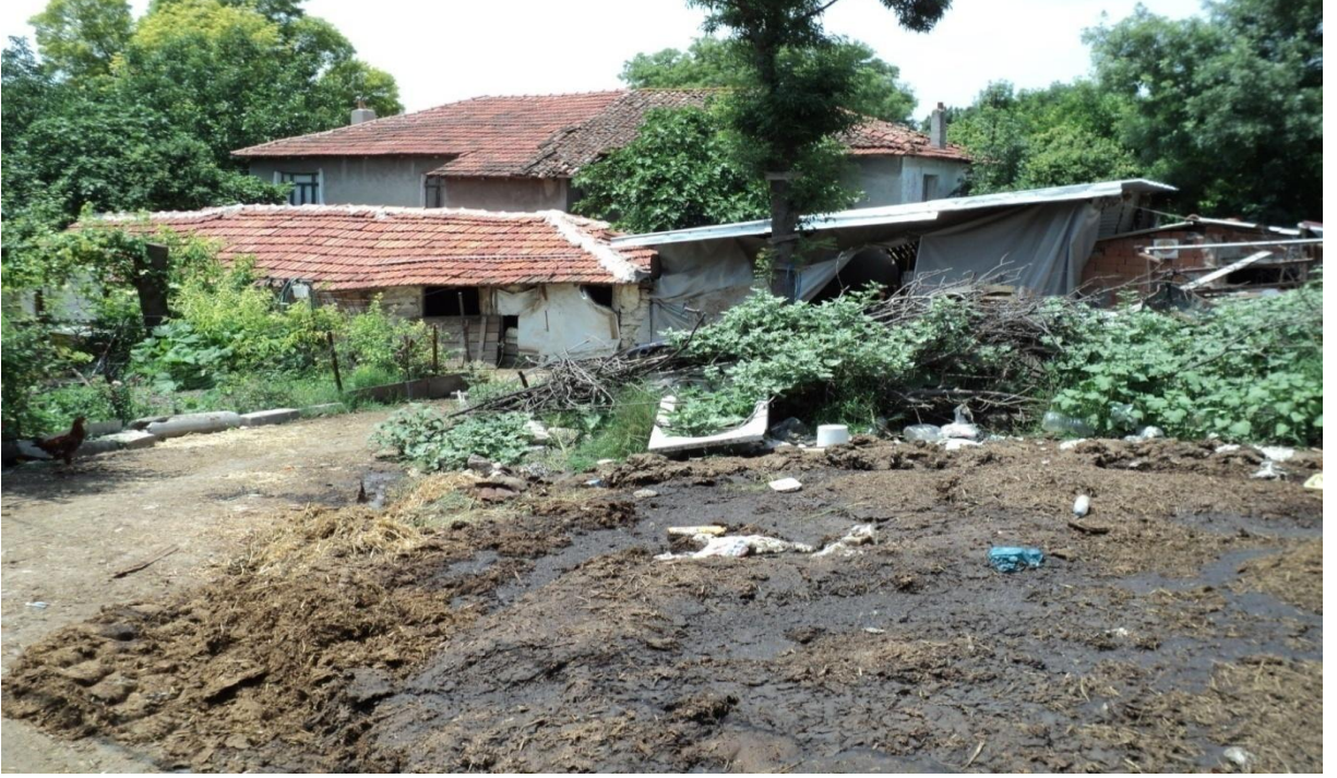
Şekil 4.5. Projesiz planlanmış bir barınağın yapısal durumu
