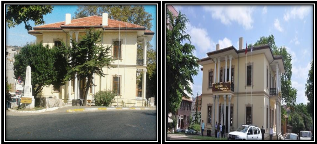
Şekil 4.45. Eski Belediye Binası Yan Görünüşü (Orijinal 2015)
