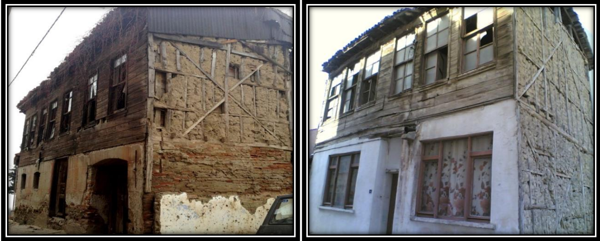
Şekil 4.65. Kerpiç dolgu dış duvar
