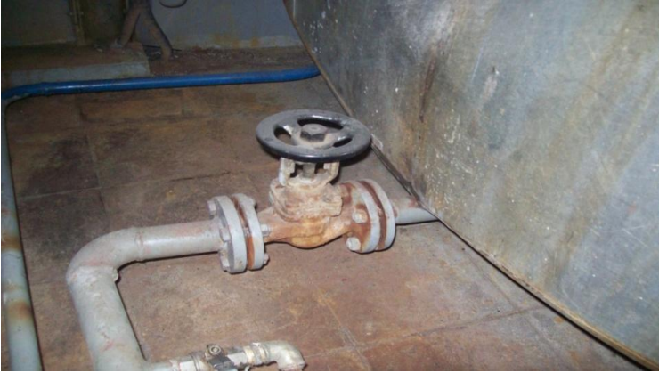
Şekil 4.17. Flanş bağlantısı (Blöf vanası)
