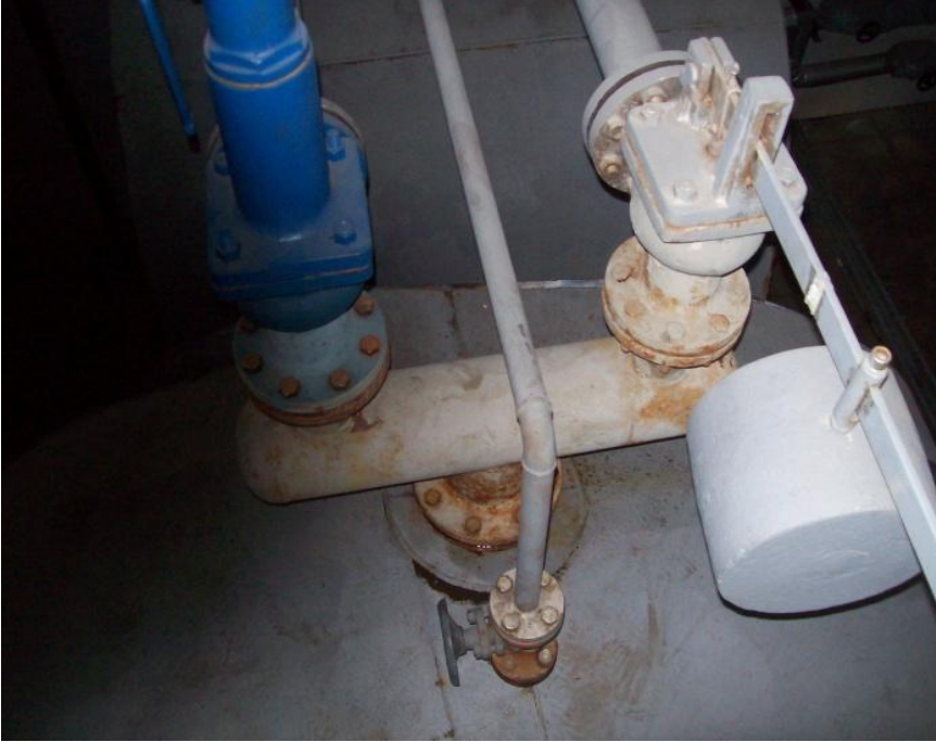
Şekil 4.7.Flanş bağlantısı ( Emniyet ventili bağlantısı)
