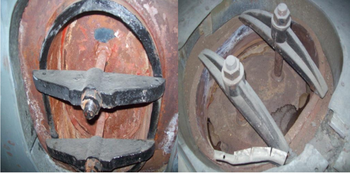
Şekil 4.14. Menhol bağlantısı
