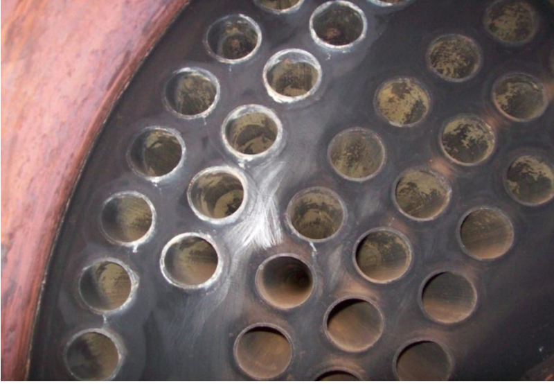
Şekil 3. 4. Alev – Duman boruları
