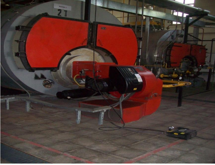
Şekil 4.9. Test pompasının buhar kazanına bağlanması
