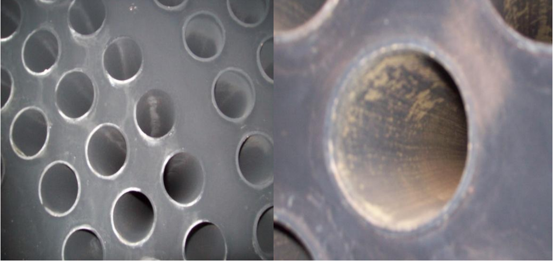
Şekil 4.4. Alev duman boruları
