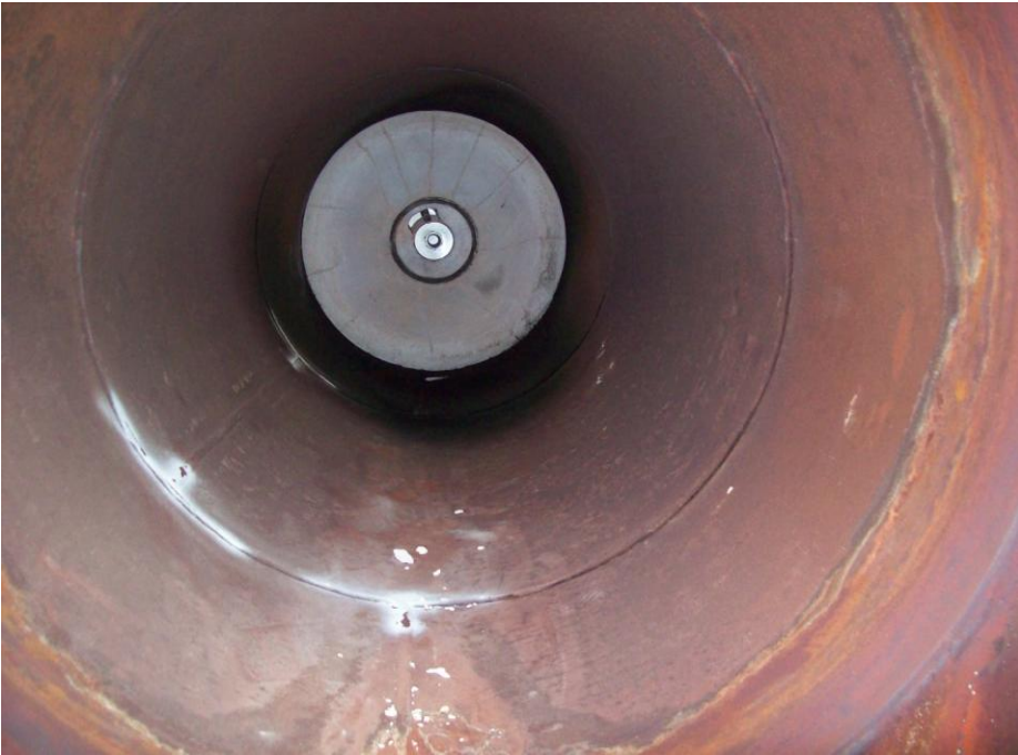
Şekil 3. 3. Isıtma kazanı cehennemlik ( iç saç )
