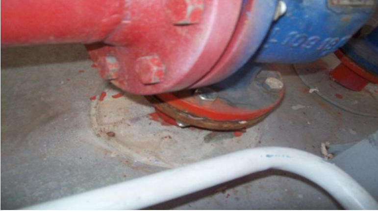
Şekil 4.15. Flanş bağlantısı ( Emniyet ventili bağlantısı)
