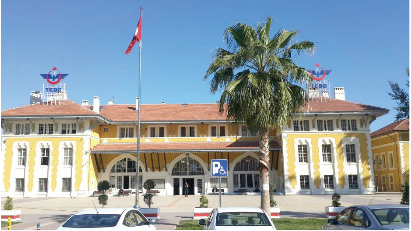
Resim: 19 Adana Gar Binası, 2016 (yazar arşivi).
