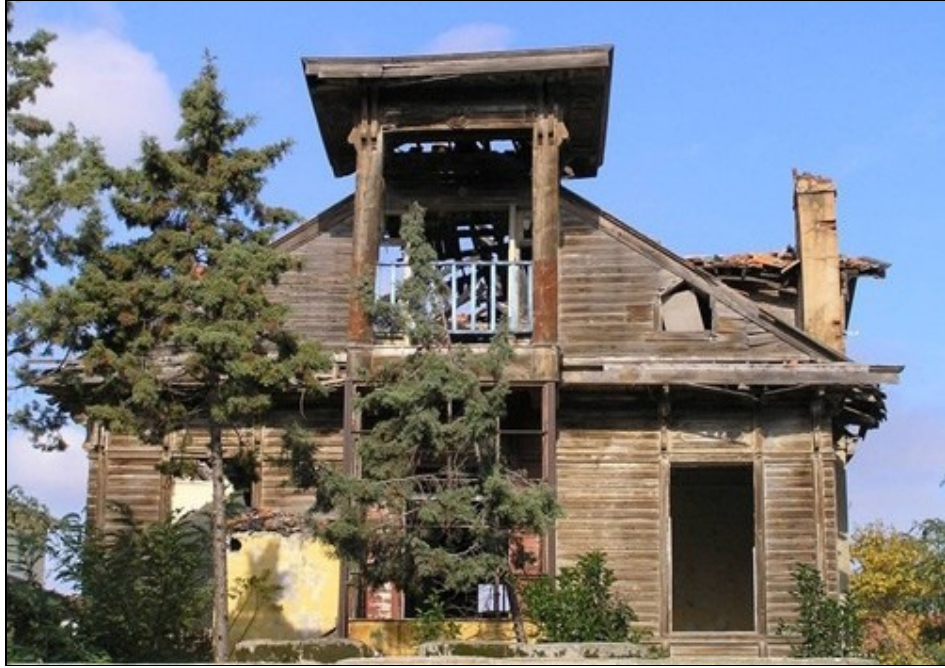
Şekil 4.36. Enver Paşa Köşkü’nün restore edilmeden önceki hali (Anonim 2009c)
