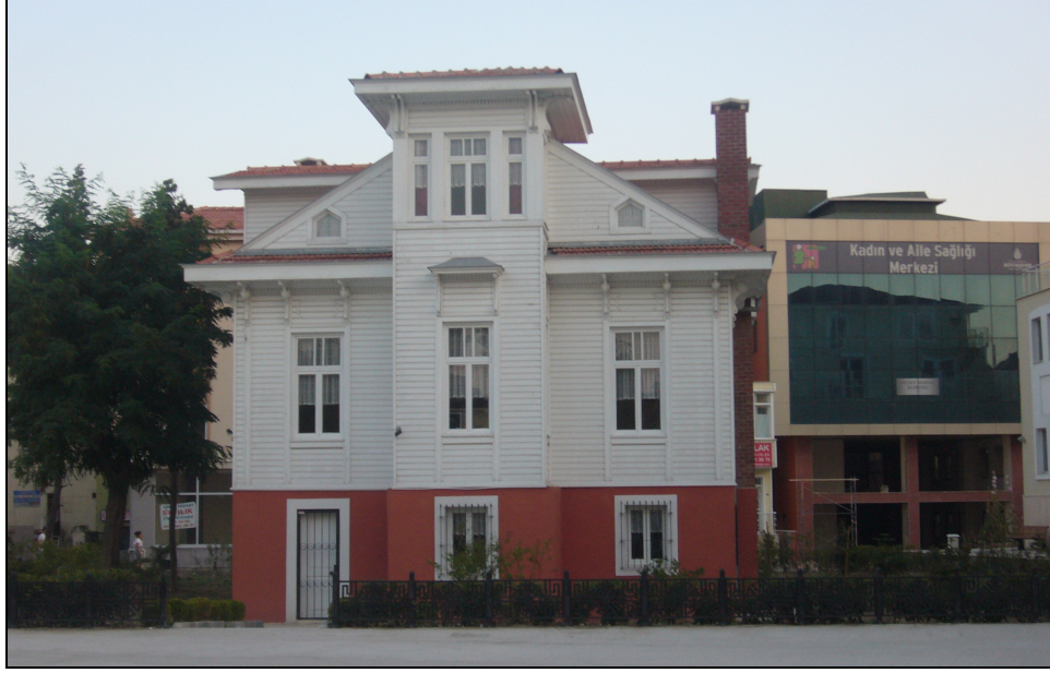
Şekil 4.37. Enver Paşa Köşkü'nün restore edildikten sonraki hali (Özgün)
