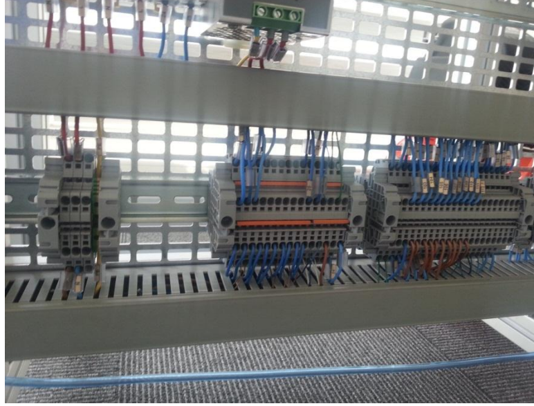
Şekil 3.11. Klemens ve kablolama sistemi
