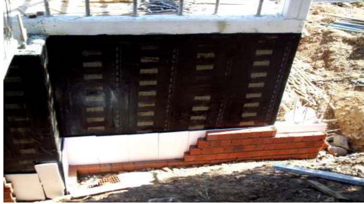
Resim 3.1 Bodrum kat ısı yalıtımında EPS uygulaması (Güzelçoban 2007).
