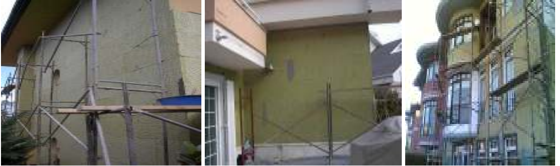
Resim 3.8 Levha şeklindeki taş yünü ısı yalıtım ürününün dış duvarlarda uygulanması (Ünar 2009).
