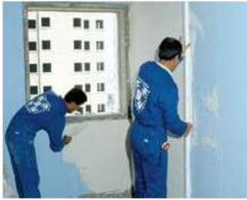
Resim 3.6 İç duvar ısı yalıtımında ve teras çatıda XPS uygulaması (Bulak Ticaret 2009).
