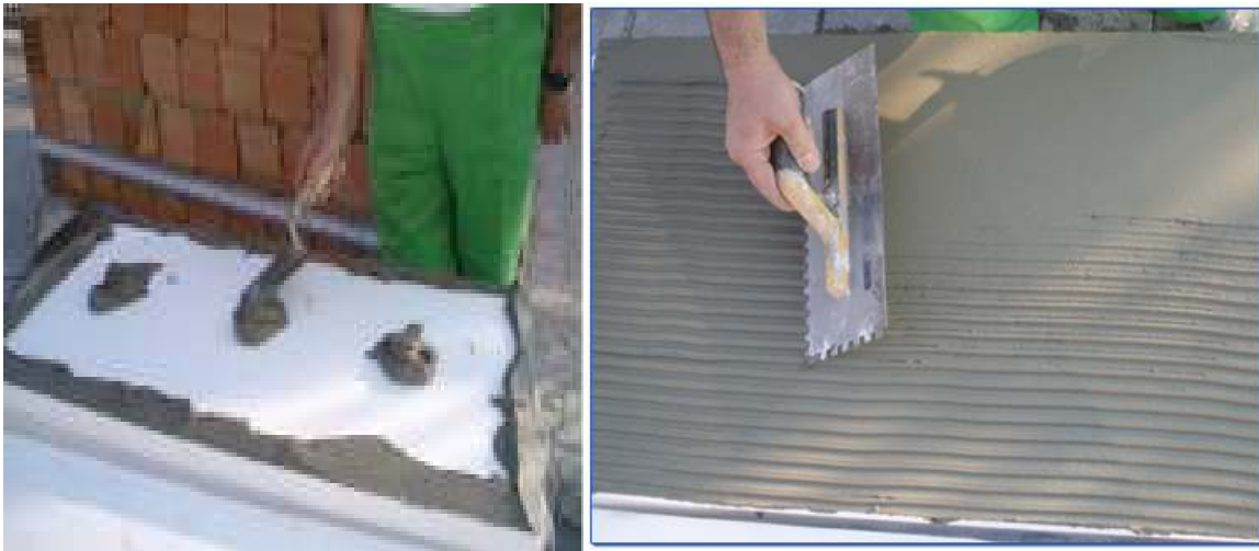
Resim 3.16 Yapıştırma harcı (Efes Isı Yalıtım Hiz. San. Tic. A.Ş. 2009).
