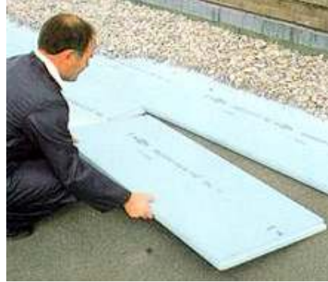
Resim 3.6 İç duvar ısı yalıtımında ve teras çatıda XPS uygulaması (Bulak Ticaret 2009).
