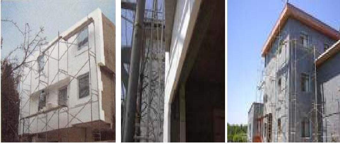
Resim 3.2 Dış duvar ısı yalıtımında EPS uygulaması (Sartema 2009).
