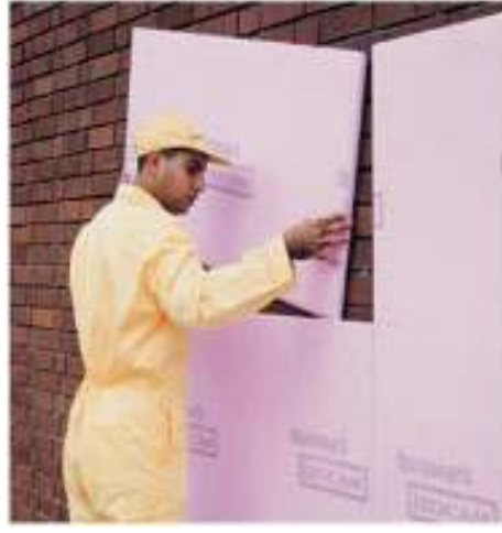
Resim 3.5 Dış duvar ısı yalıtımında ve teras çatıda XPS uygulaması (Dow Building Solutions ve Sivas Demir Çekme Sanayi Ltd. Şti. 2009).
