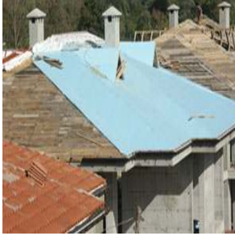
Resim 3.5 Dış duvar ısı yalıtımında ve teras çatıda XPS uygulaması (Dow Building Solutions ve Sivas Demir Çekme Sanayi Ltd. Şti. 2009).
