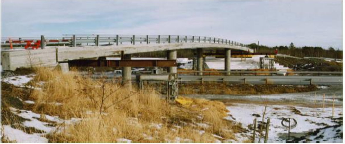
Şekil 2.21. Hjelmungen Köprüsü EPS geofom dolgu inşaatı (Aabø ve Frydenlund, 2011)
