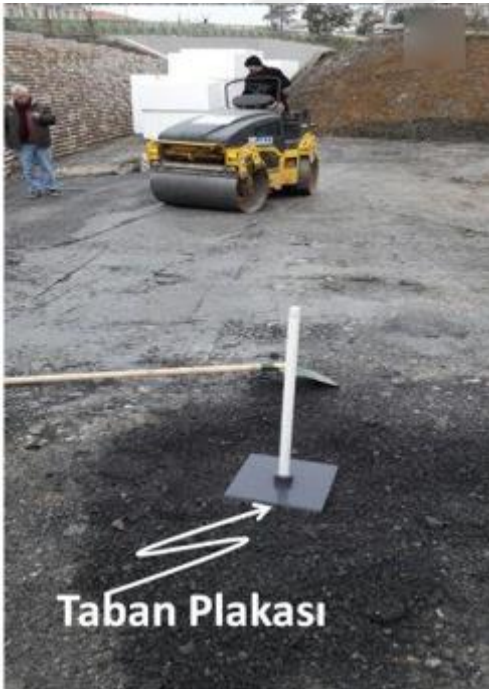
Ŗekil 2.25. Taban plakasının EPS dolgu altına yerleŖtirilmesi (zer vd., 2017)
