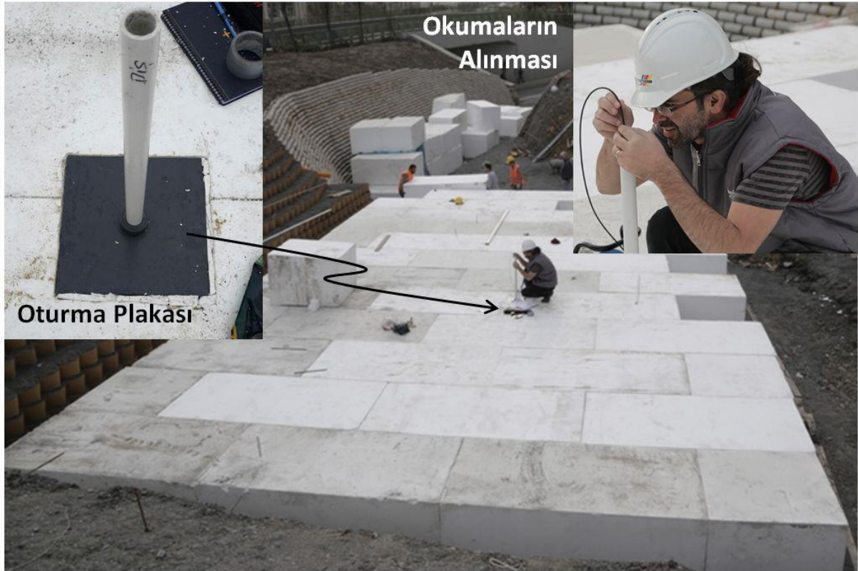
Şekil 2.26. EPS geof foam dolgu üzerine oturma plakasının yerleştirilmesi (Özer vd., 2017)
