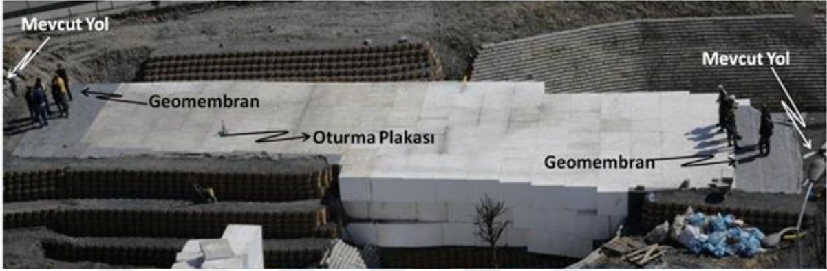
Ŗekil 2.24. EPS bloklar ile mevcut yol arayznde yapılan EPS uygulaması (zer vd., 2017)
