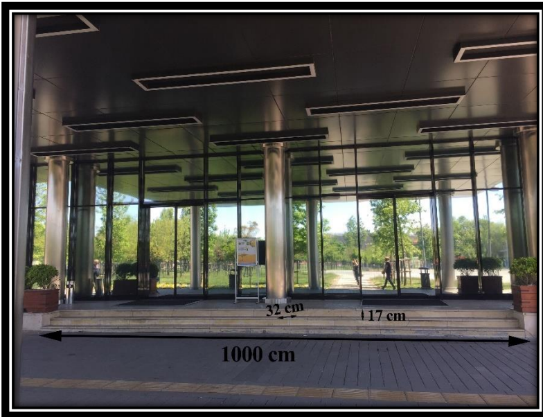
Şekil 4.14. Sosyal tesis girişindeki merdivenler
