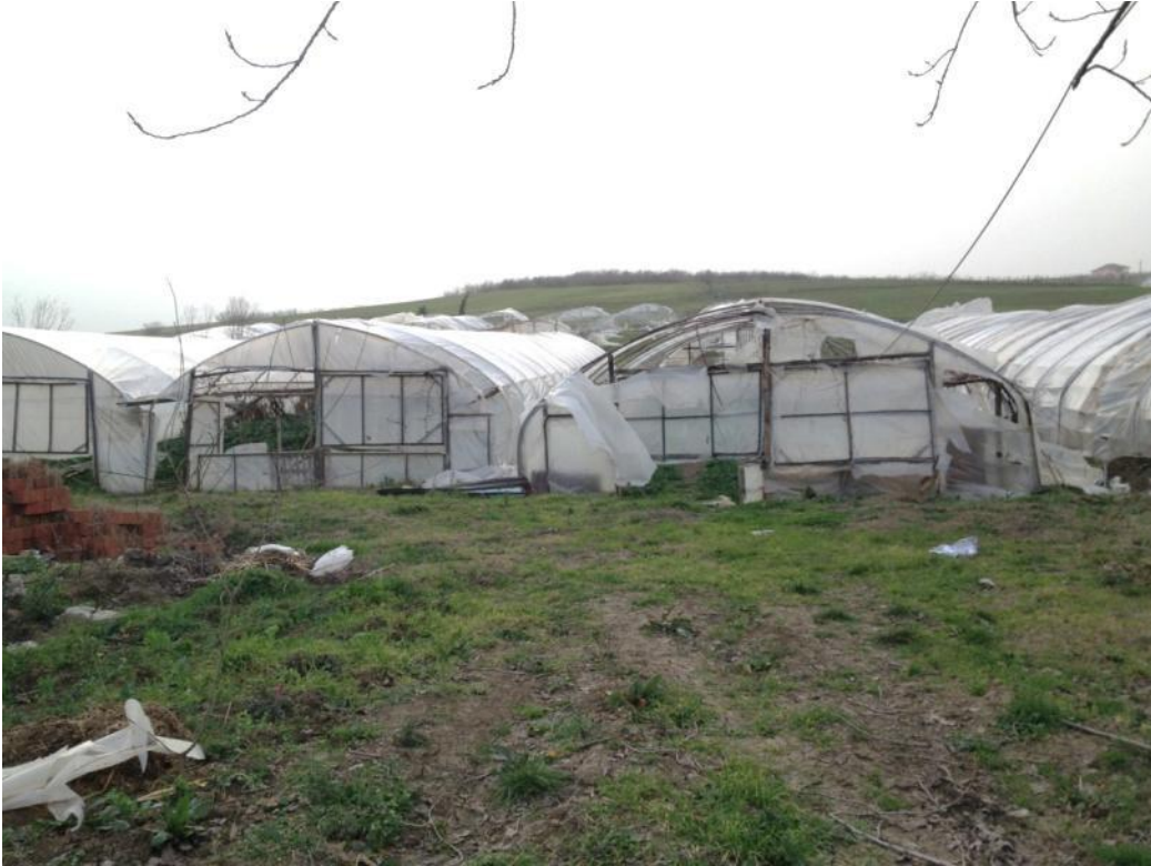
Şekil 4.15. Rüzgar yükü sonucu örtü malzemesinde oluşan zarar (Yalova-İşletme no:2)
