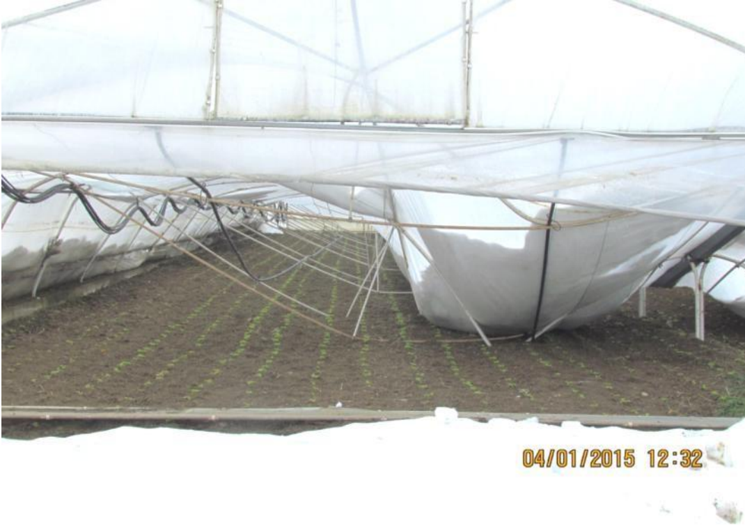
Şekil 4.28. Kar yükü sonucu konstrüksiyonda oluşan zarar (Yalova-İşletme no:10)
