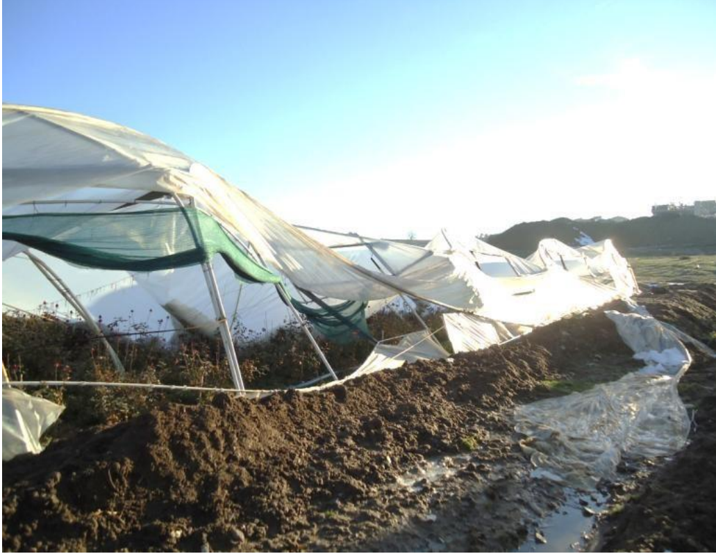
Şekil 4.27. Kar yükü sonucu örtü malzemesinde oluşan zarar (Yalova-İşletme no:9)
