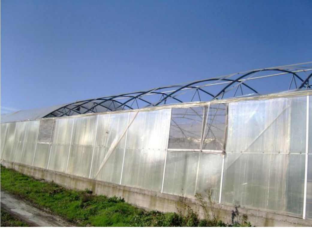
Şekil 4.17. Rüzgar yükünün seraya verdiği zarar (Yalova-İşletme no:4)
