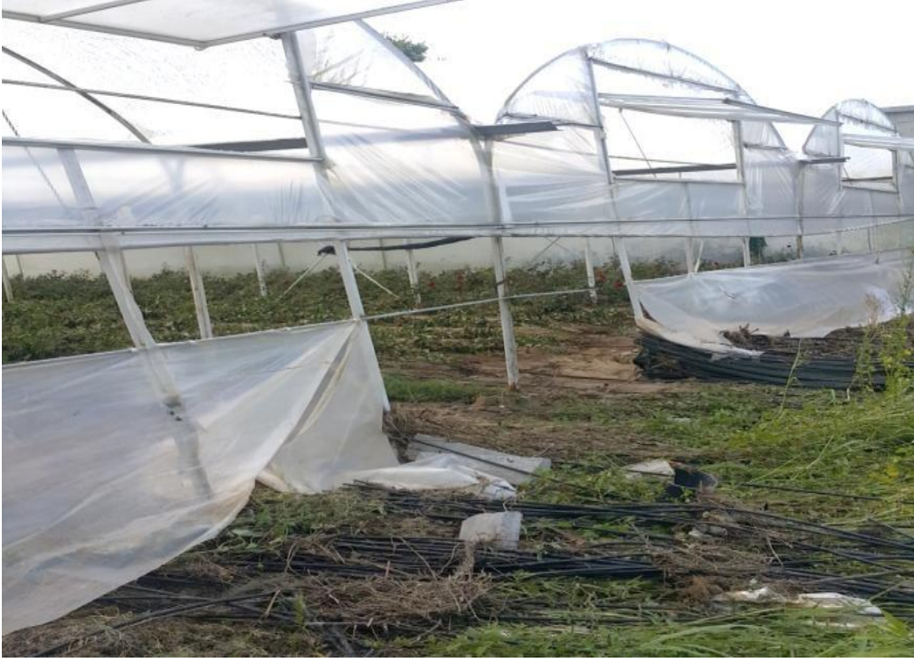
Şekil 4.1. Uygun yerde yapılmayan serada su baskını zararı (Yalova-İşletme no:5)
