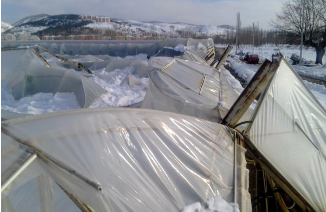
Şekil 4.24. Kar yükü sonucu ağaç konstrüksiyonda meydana gelen zarar (Yalova-İşletme no:7)
