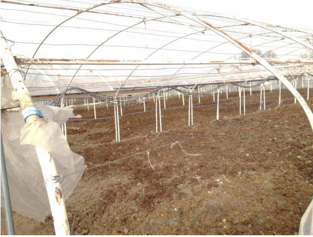
Şekil 4.15. Rüzgar yükü sonucu örtü malzemesinde oluşan zarar (Yalova-İşletme no:2)
