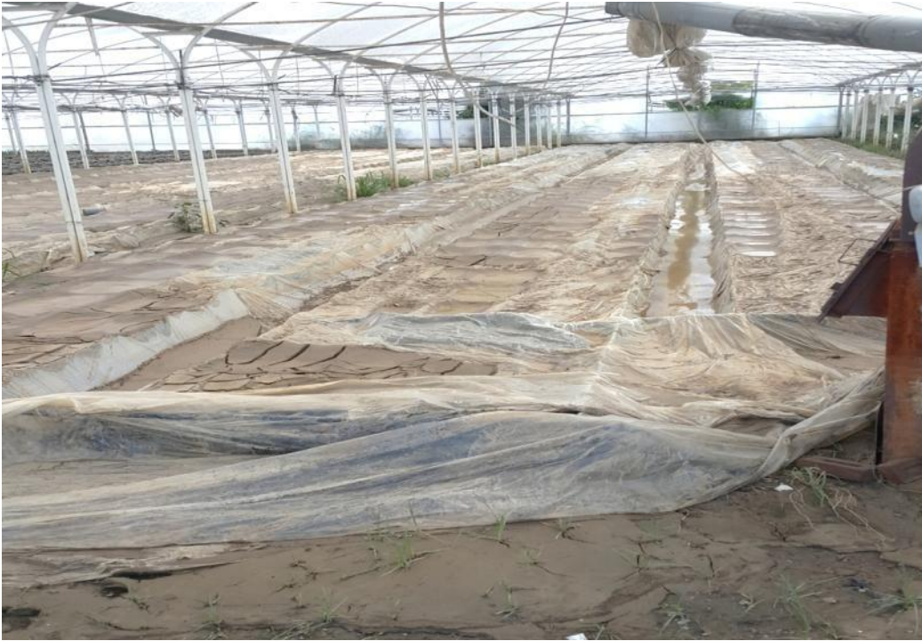
Şekil 4.2. Uygun yerde yapılmayan serada su baskını zararı (Yalova-İşletme no:6)
