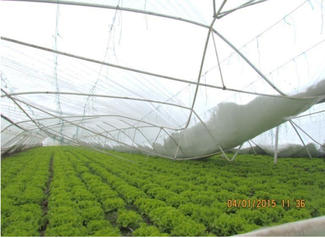
Şekil 4.28. Kar yükü sonucu konstrüksiyonda oluşan zarar (Yalova-İşletme no:10)
