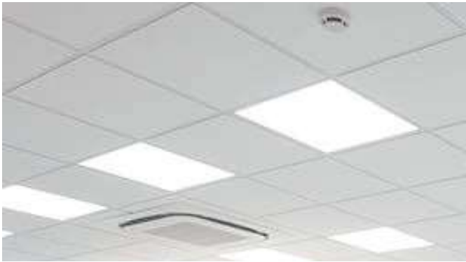
Şekil 2.2. Asma tavanlara yerleştirilen cam elyafından üretilmiş yapılar
