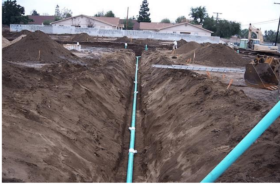
Şekil 2.2. Şevli kanal kazısı örneği [8]
