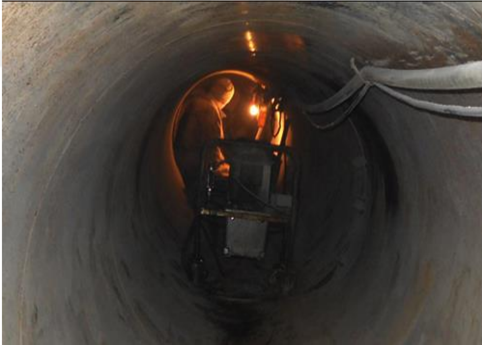
Şekil 3.4. Konvansiyonel sistem ile boru sürme yöntemi [23]
