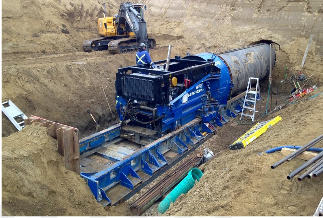
Şekil 3.6. Helezonlu yatay delgi metodu ile boru sürme [26]
