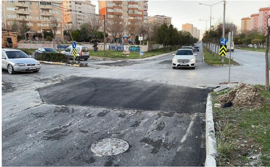
Şekil 4.1. Yama asfalt uygulamaları
