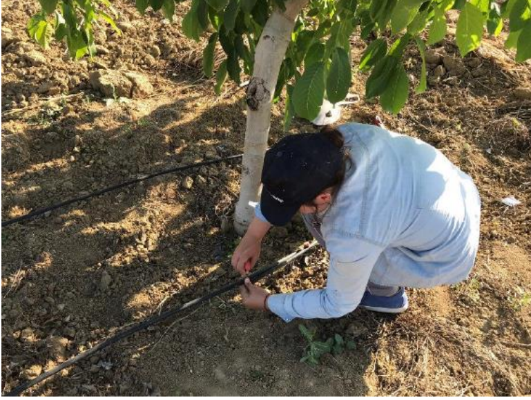
Şekil 3.15. Laterallerin ve damlatıcıların yerleştirilmesi
