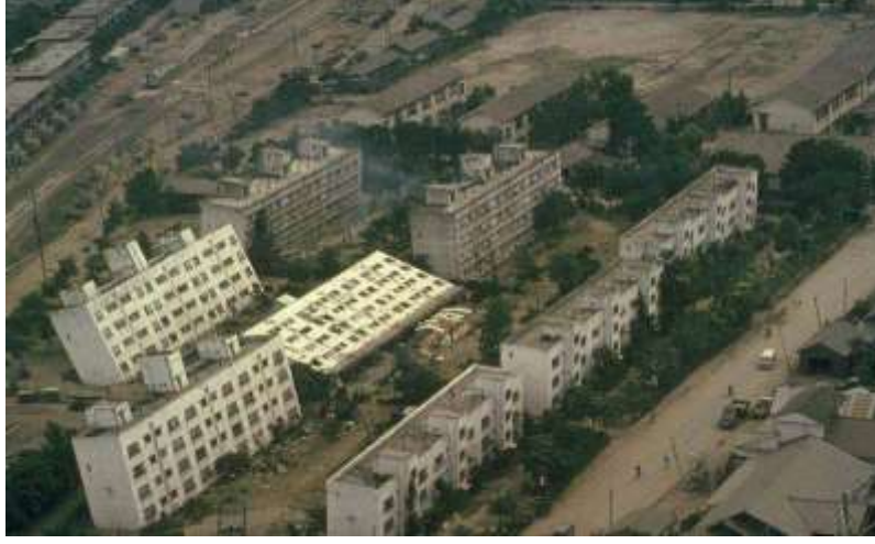
Şekil 3.7. 1964 Niigata depreminde sıvılaşma sonucu yana yatmış binalar (Anonim 2018)
