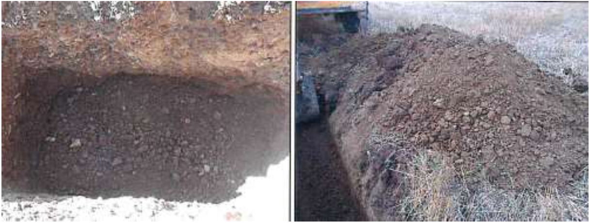
Şekil 4.6. Araştırma çukuru çalışmalarında görünüm
