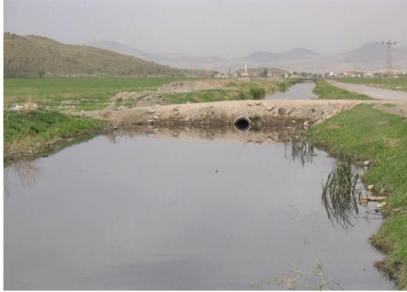
Şekil 3.6. Dere yatağının kapatılması
