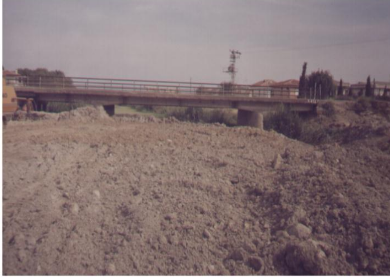
Şekil 3.3. Dere yatağına malzeme yığılması
