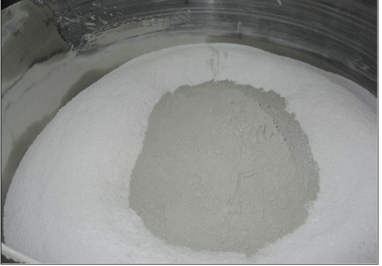
Şekil 3.7. Karışım Suyu Eklenmeden Önceki Durum
