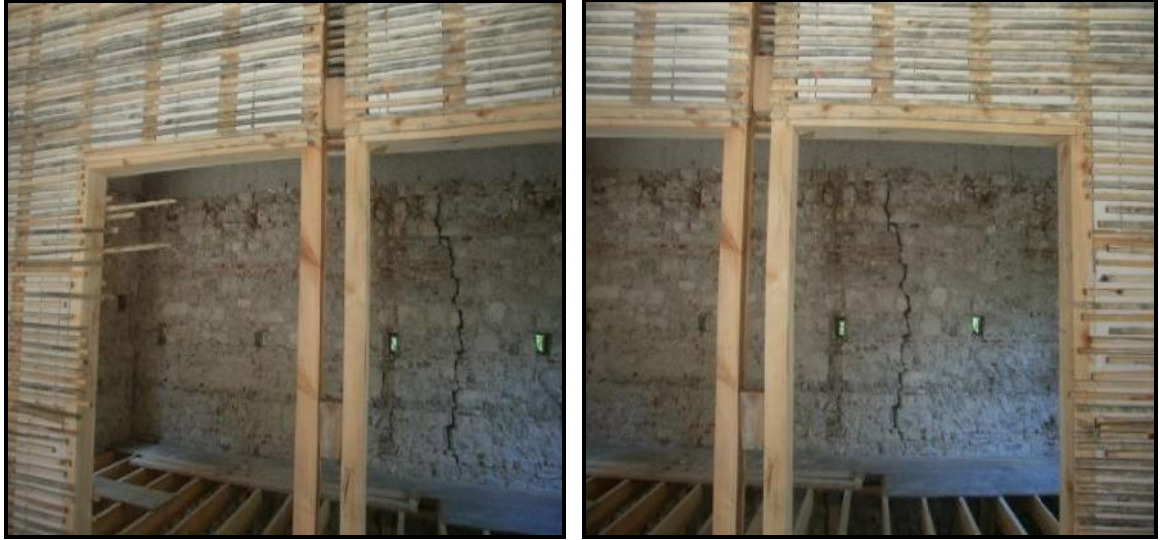
ekil 4.19. Mü temilat Binası Ah ap Karkas Görünü (Sepetci arşiv)
