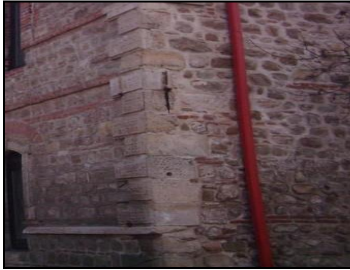
ekil 2.18. Do al Ta Duvar (Sepetçi ar iv)
