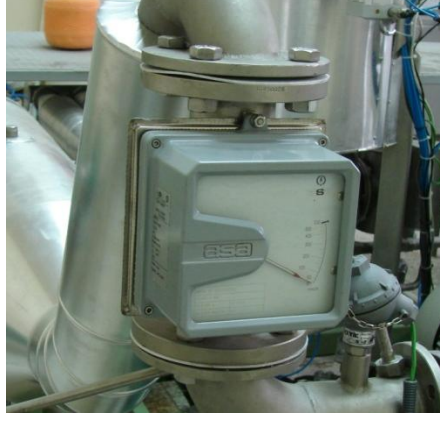
Şekil 3.7 Debimetre
