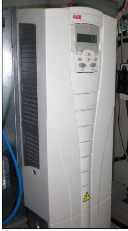
Şekil 3.14 Sürücü (İnvertör)
