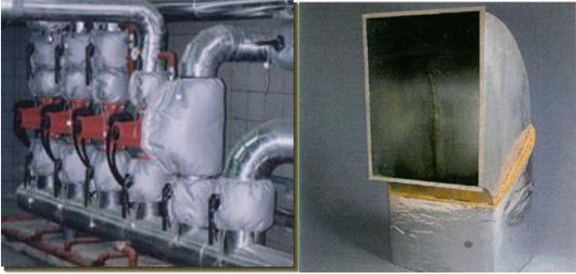
Şekil 3.13. Yalıtımı Yapılmış Bir Teshin Merkezi ve Klima Kanalı (www.yalitim.net)
