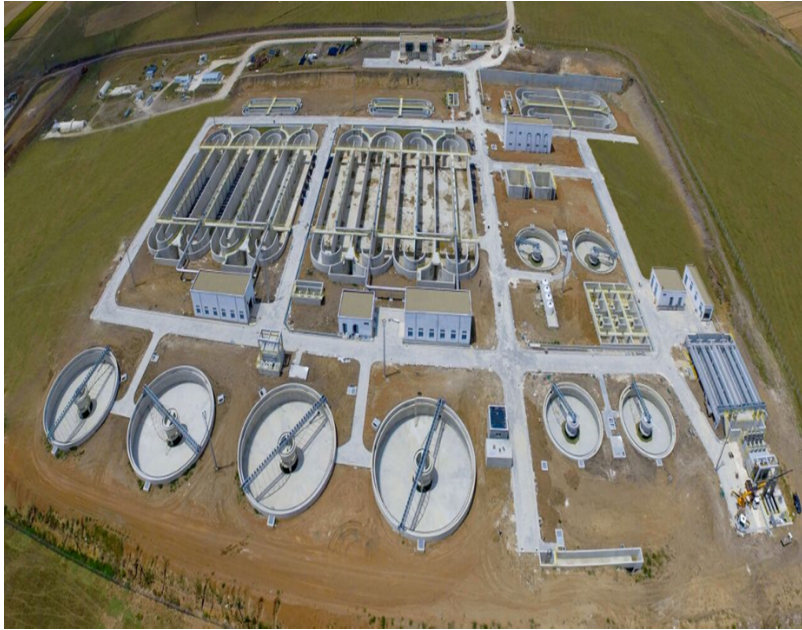
Şekil 1.8:Evsel ve Endüstriyel Atıksu Arıtma Tesisi
