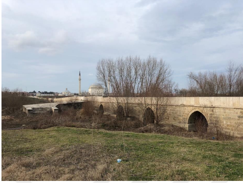
Şekil 4.32. Yalnızgöz Köprüsü (Orijinal, 2019)
