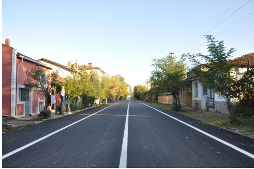
Şekil 4.43. Karaağaç Mahallesi'nde yer alan sivil mimarlık örnekleri (Orijinal, 2019)
