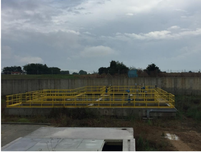
Şekil 3.18. Hızlı ve Yavaş Karıştırıcı Ünitesi
