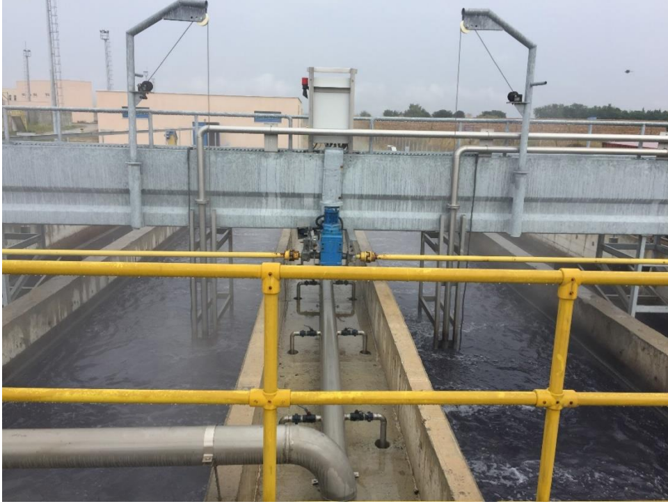
Şekil 3.9. Havalandırılmalı Kum ve Yağ Tutucu Ünitesi
