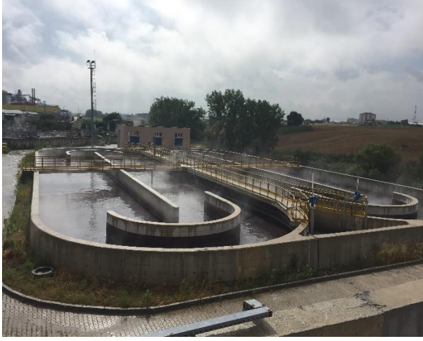
Şekil 3.10. Dengeleme Havuzu
