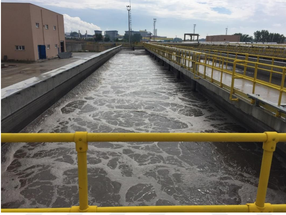
Şekil 3.14. Havalandırma Havuzları
