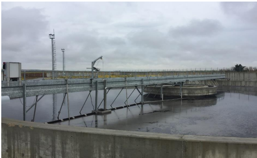
Şekil 3.17. Biyolojik Çöktürme Havuzu
