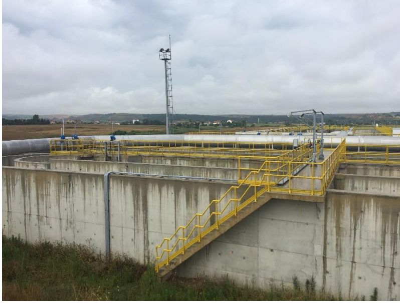
Şekil 3.12. Anaerobik Biyofosfor Ünitesi
