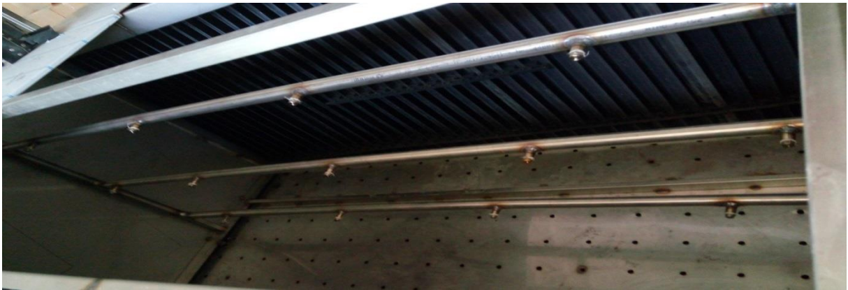
Şekil 3.12. Wet Scrubber (ıslak yıkama) Ünitesi
