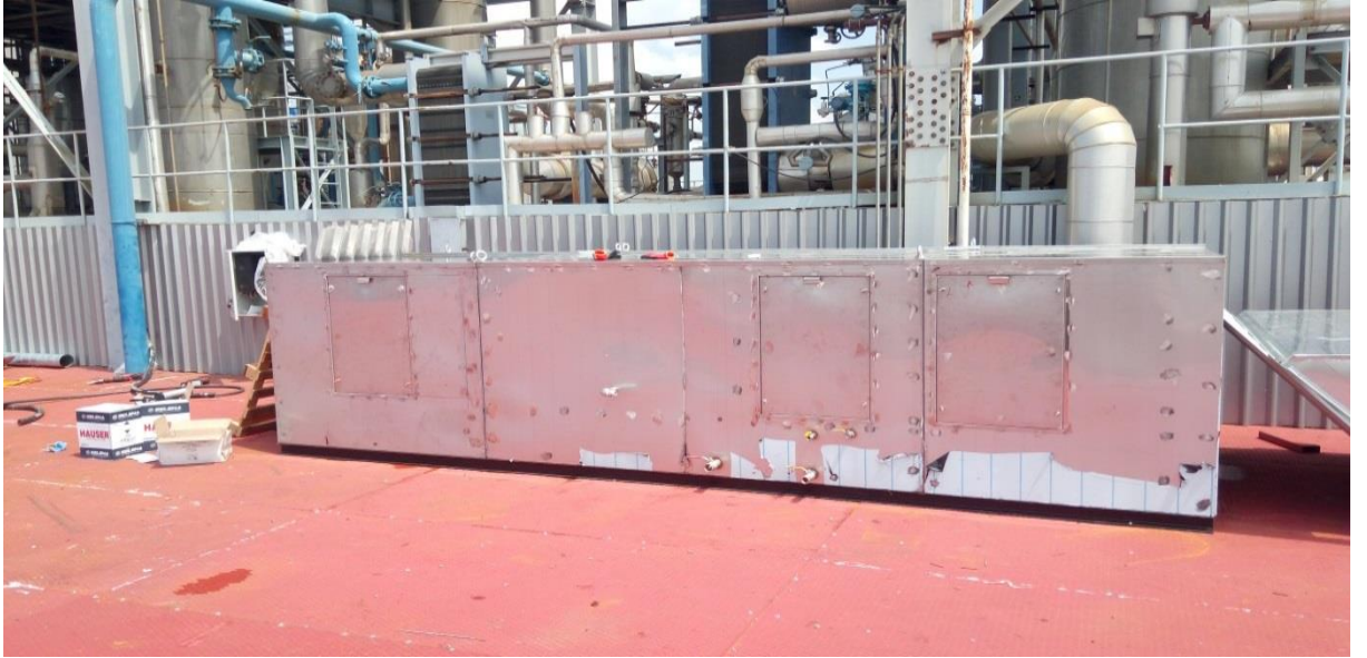
Şekil 3.5. Aktif karbon ile kombine edilmiş scrubber sistemin genel görünümü
