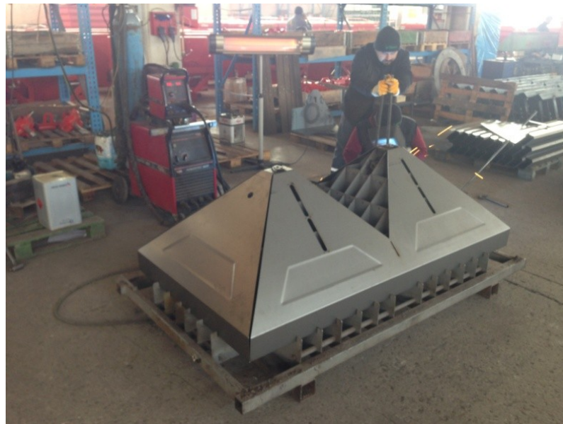
Şekil 3.31. Seri iş montaj kalıbı kullanılarak, punta kaynağının yapılması
