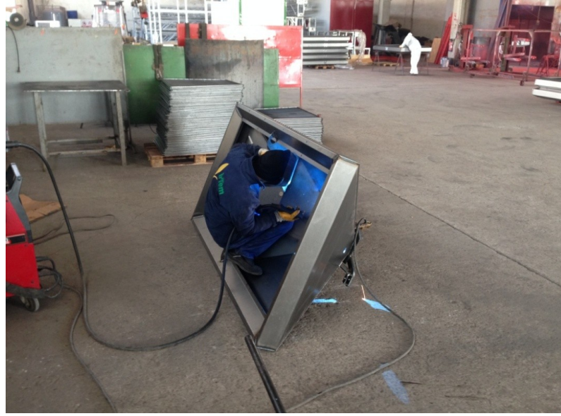
Şekil 3.33. Montaj kalıbında kaynaklanamayan bölgelerin kaynak işlemlerinin yapılması
