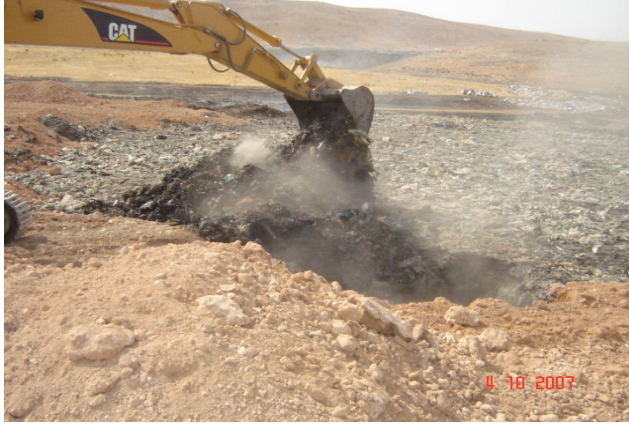
Şekil 5.9 Vahşi Döküm Alanı Islah Çalışmaları
