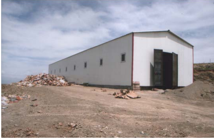
Şekil 5.3 Ambalaj Atıkları Ayrıştırma Tesisi
