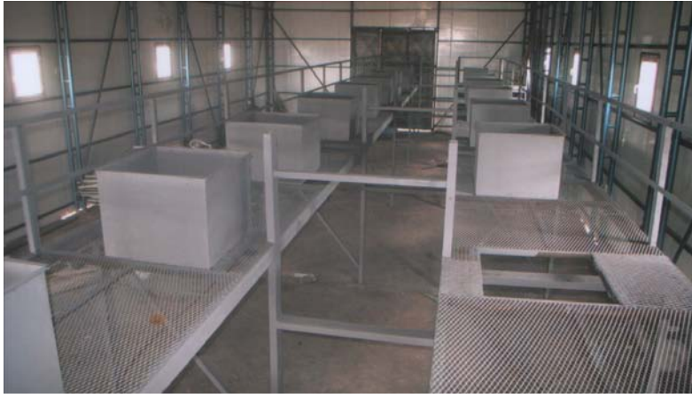
Şekil 5.4 Ambalaj Atıkları Ayrıştırma Tesisi –İmalat Aşaması
