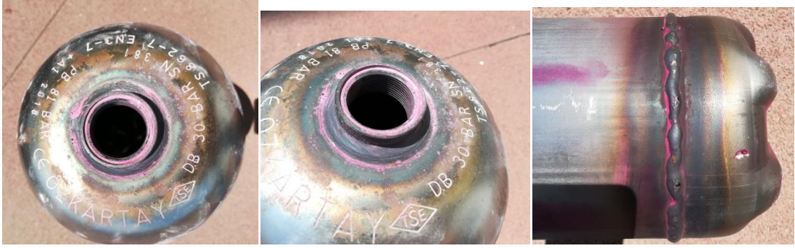
Şekil 4.5. İki numaralı tüpün kaynak bölgelerine penetrant sıvı uygulamasının sonucu
