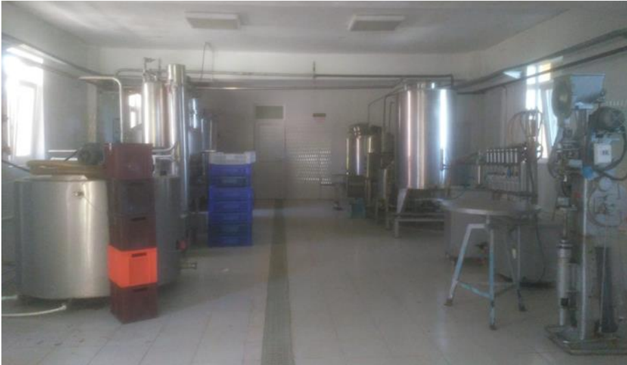
Şekil 3.3. Üzüm suyu işleme tesisinin genel görünümü
