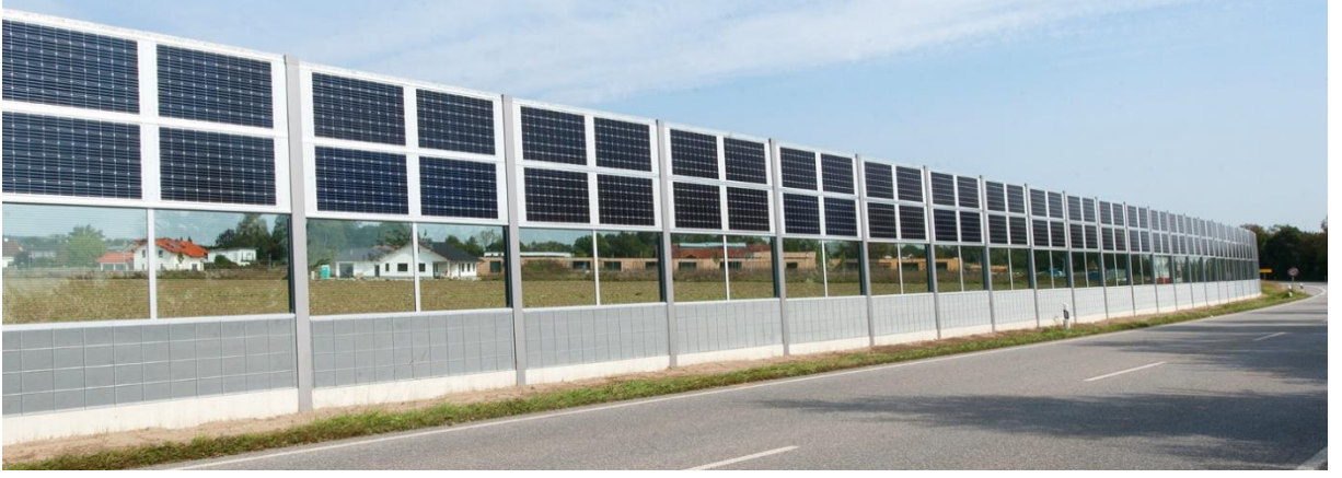
Şekil 6.8. Güneş enerjili gürültü bariyeri örneği (Anonim 2019c)
