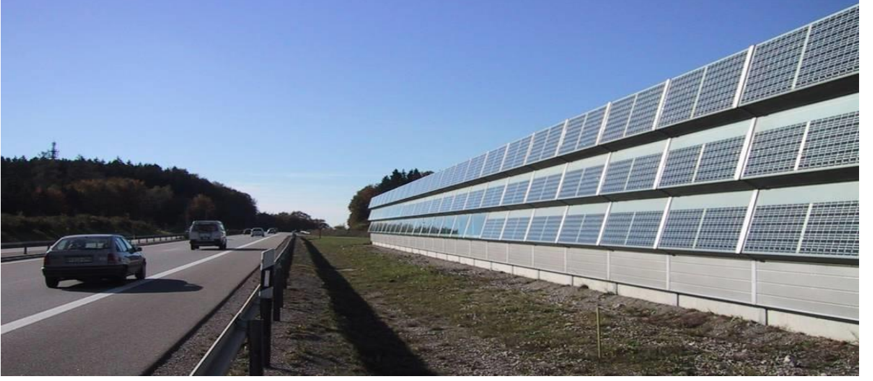
Şekil 6.7. Güneş enerjili gürültü bariyeri örneği (Anonim 2019c)
