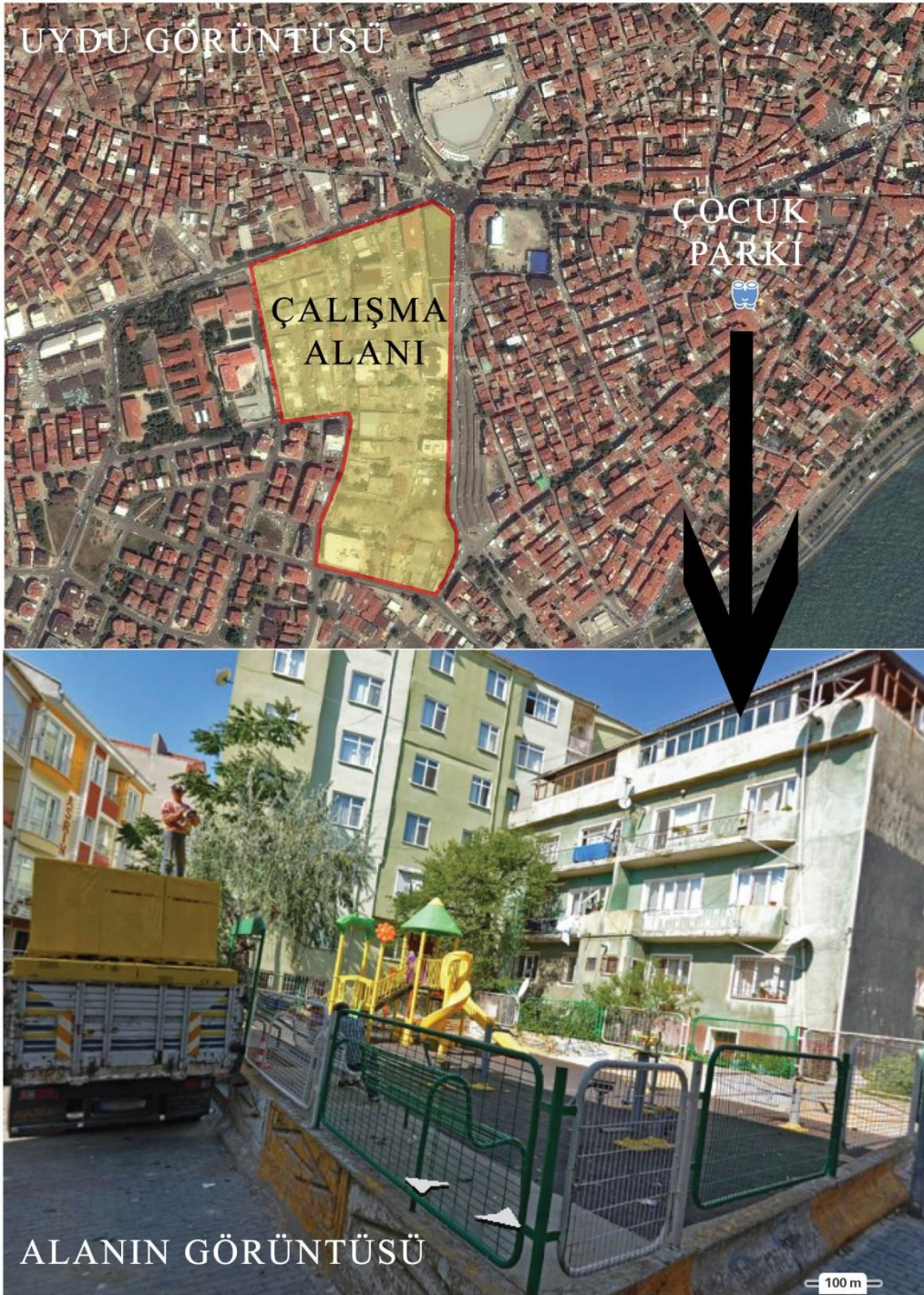
Şekil 5.9. Yavuz Mahallesi Çocuk Parkı-2
