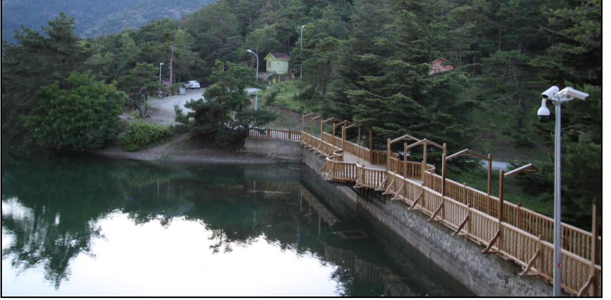
Şekil 4. 42. Ahşap Köprüden Görünüm
