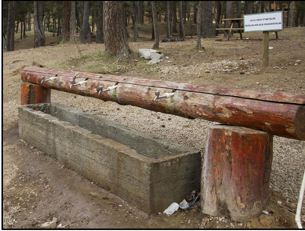
Şekil 4. 33. Alandaki Çeşmelerden Görünüm
