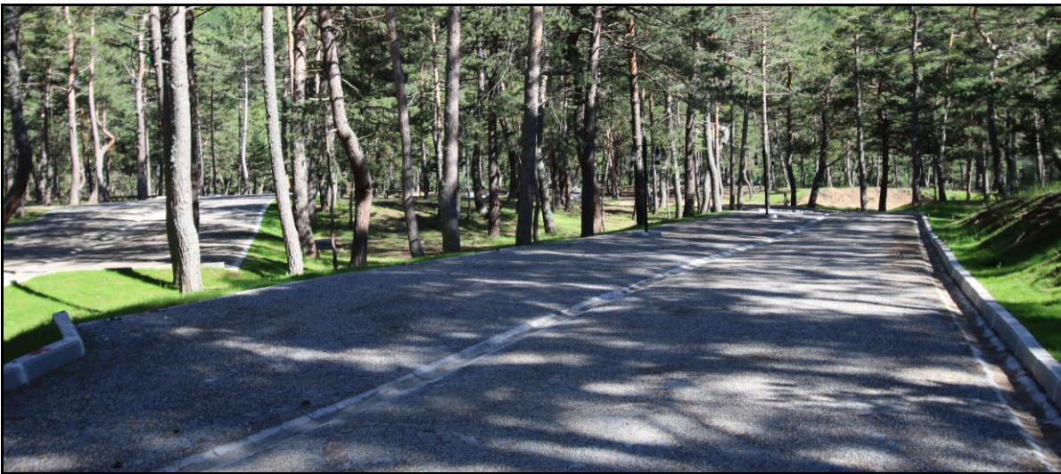
Şekil 4. 49. Araç yolu ve otoparktan görünüm
