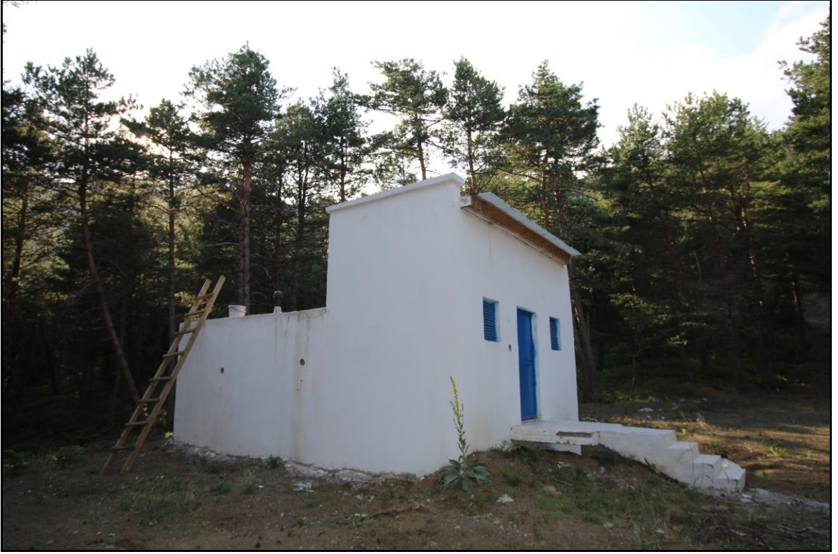
Şekil 4. 18. Su Deposundan Görünüm
