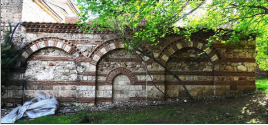
Görsel 19. Eski Kaplıca Ihlık Bölümü Batı Cephe
