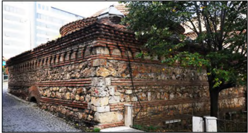
Görsel 21. Eski Kaplıca Sıcaklık Bölümü Güney Doğu Cephe
