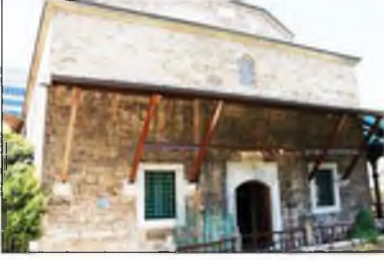
Görsel 3. Bursa Eski Kaplıca Doğu (Kadınlar Bölümü) Giriş Kapısı
