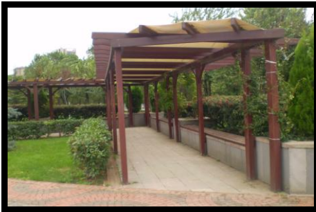
Şekil 18. Özgürlük Parkı’nda pergola Figure 18. Özgürlük Park pergola
