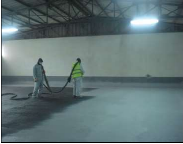
Şekil 1.5. Poliüre uygulaması (Anonim 2014)
