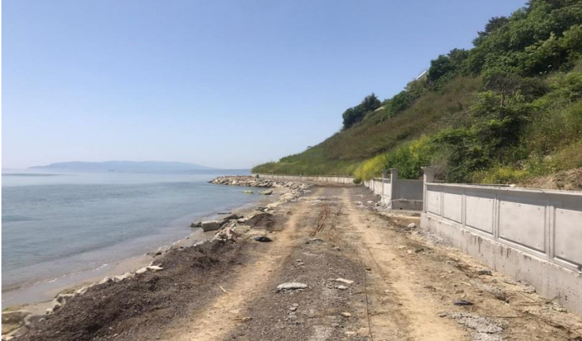
Şekil 4.49. Hürriyet Mahallesi sahil şeridi yapımına başlanan yürüyüş yolu çalışması
