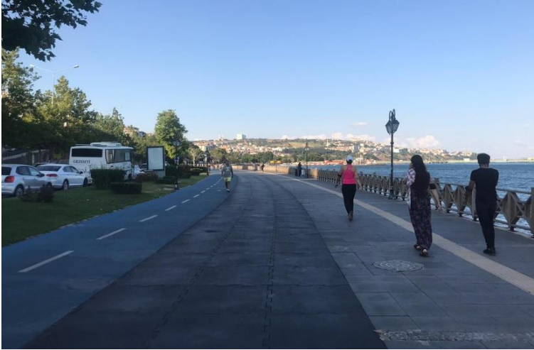
Şekil 4.29. Gündoğdu Mahallesi sahil şeridi bisiklet, yürüyüş ve koşu yolu kullanım örneği
