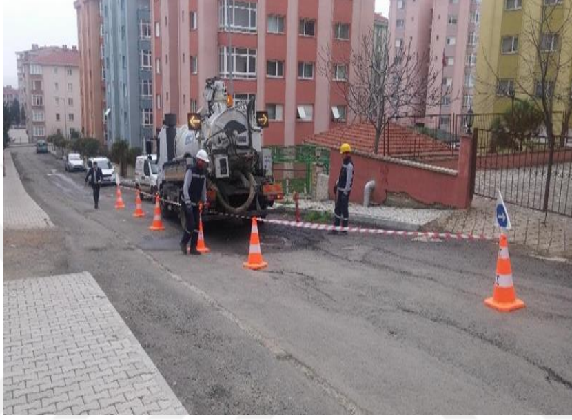
Şekil 4.18. Kombine kanal açma aracı ile çalışmalarda trafik tedbirleri
