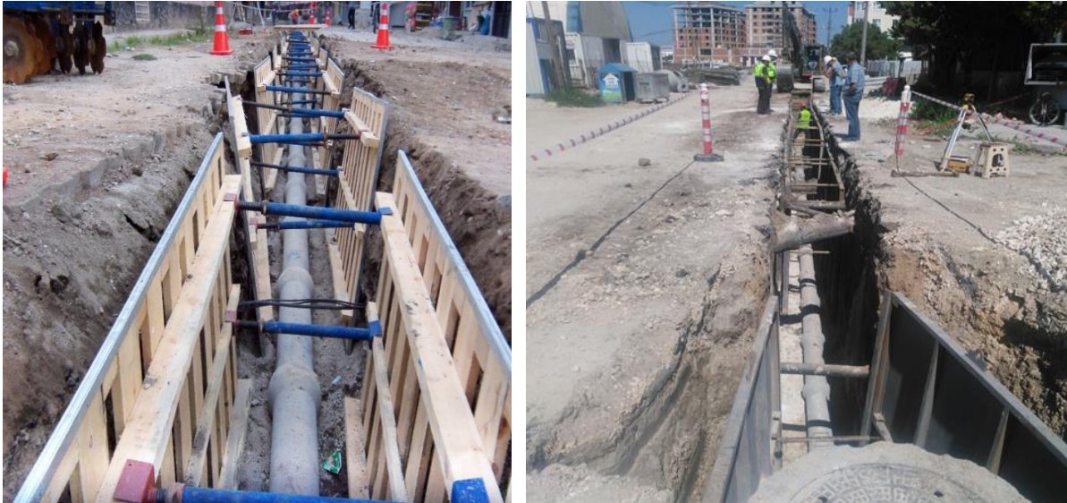
Şekil 4.13. Kanalizasyon hattı inşasında ahşap ve çelik panolu iksa kullanımı
