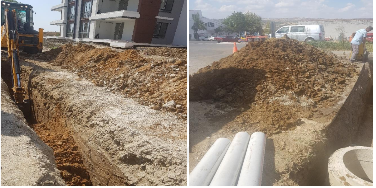
Şekil 4.11. Kazı toprağının yerleştirilmesi
