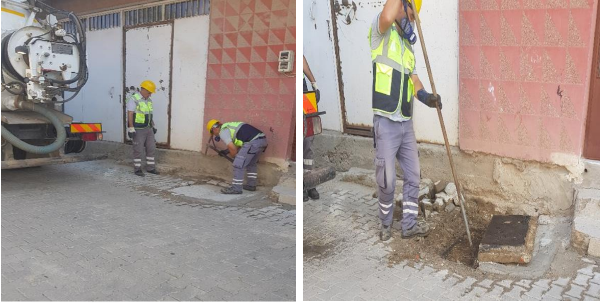
Şekil 4.19. Muayene/Parsel baca kapağının kaldırılması ve havalandırılması
