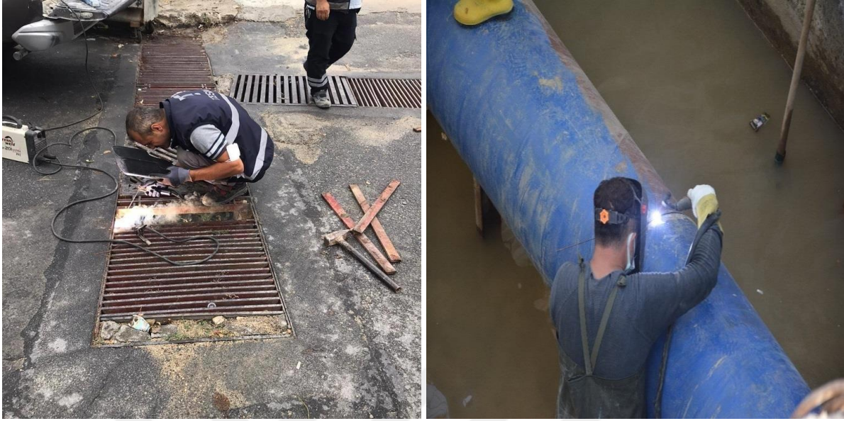
Şekil 4.16. Kaynak yapılması sırasında KKD kullanımı
