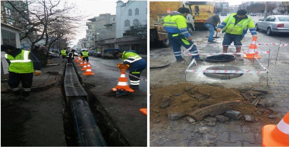
Şekil 4.7. Bakım onarım arıza işlerinde trafik tedbirlerinin alınması
