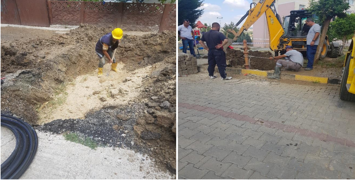
Şekil 4.8. Bakım onarım arıza işlerinde KKD kullanımı
