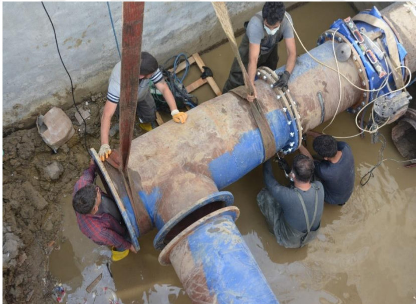
Şekil 4.15. Özelliğini yitirmiş sapan kullanımı
