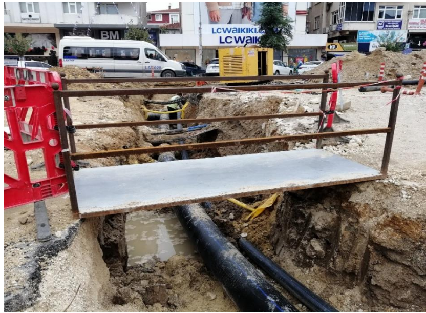
Şekil 4.17. Kazı alanında geçiş platformu kullanılması
