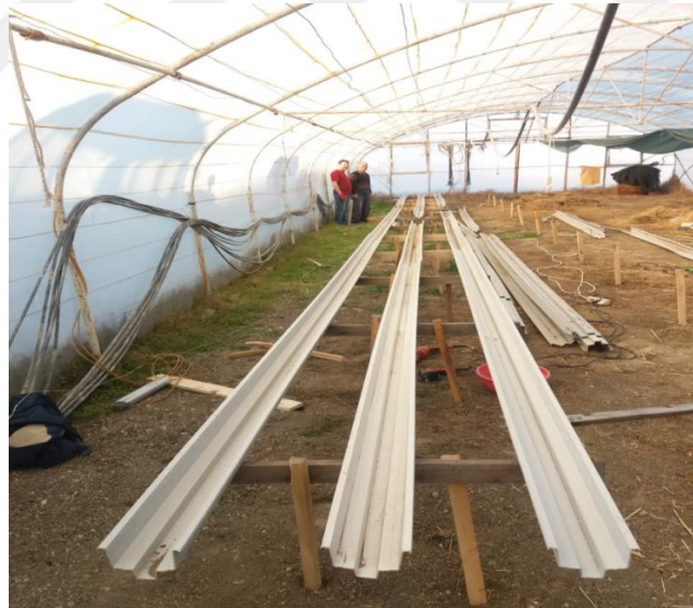
Şekil 2.2. Kokopit doldurulmuş torbaları taşıyan kanalların ayaklı iskelet üzerine oturtulması
